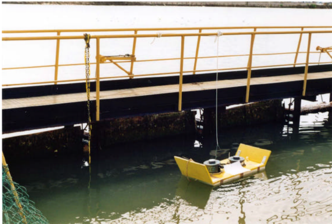
Fig. AI-12 Andamento temporale della temperatura registrata nella stazione canale artificiale Candiano – opera di presa della centrale e fotografia del punto di installazione dello strumento
