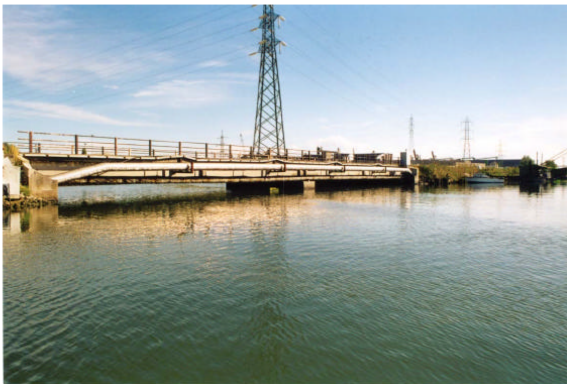
Fig. AII-15 Andamento temporale della temperatura registrata nella stazione canale artificiale Magni – opera di scarico della centrale e fotografia del punto di installazione dello strumento
