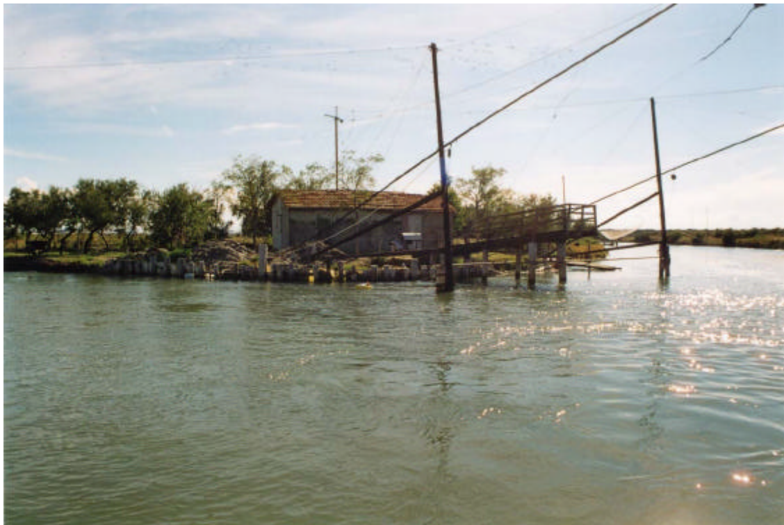
Fig. AII-4 Andamento temporale della temperatura registrata nella stazione canale artificiale Fossatone – stazione settentrionale e fotografia del punto di installazione dello strumento
