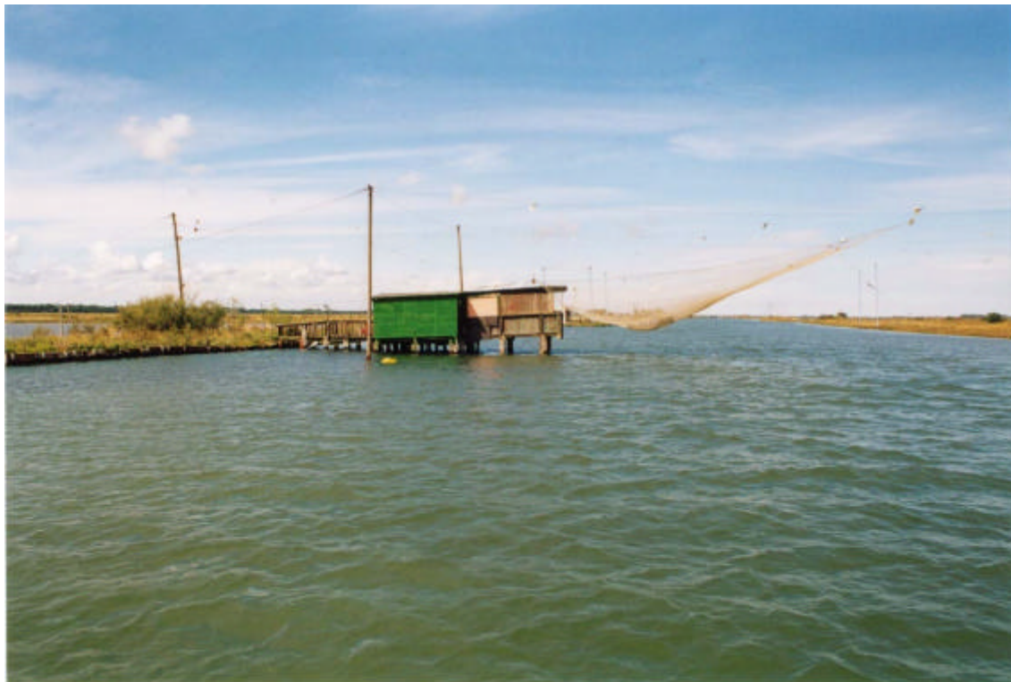
Fig. AI-9 Andamento temporale della temperatura registrata nella stazione canale artificiale Baccarini – stazione intermedia meridionale e fotografia del punto di installazione dello strumento
