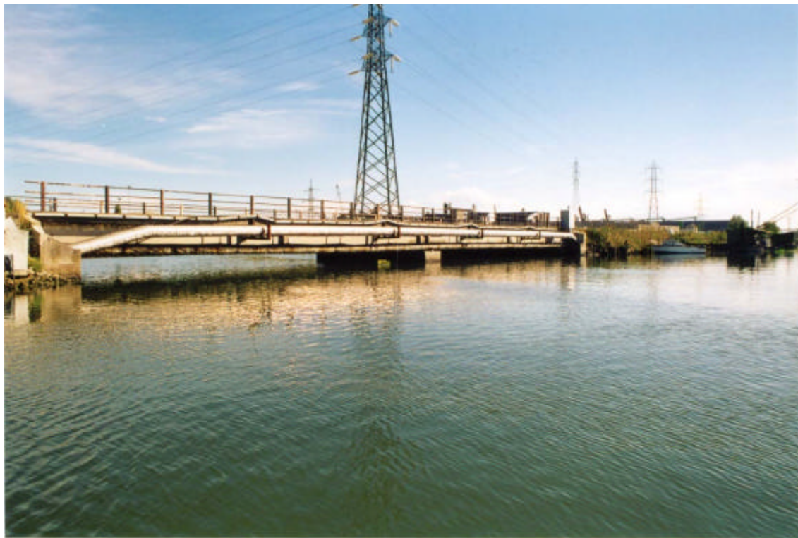
Fig. AI-15 Andamento temporale della temperatura registrata nella stazione canale artificiale Magni – opera di scarico della centrale e fotografia del punto di installazione dello strumento
