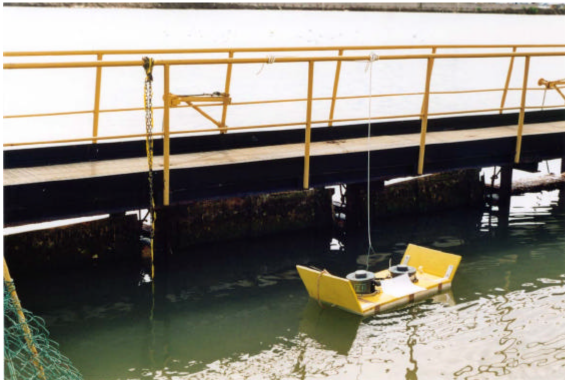
Fig. AI-10 Andamento temporale della temperatura registrata nella stazione canale artificiale Candiano – opera di presa della centrale e fotografia del punto di installazione dello strumento
