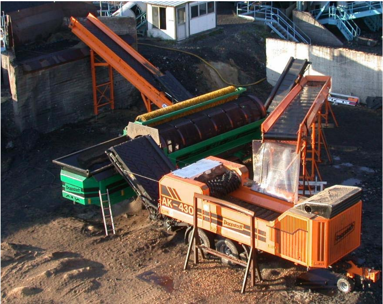
Figura 3: Disposizione caratteristica macchinari.
