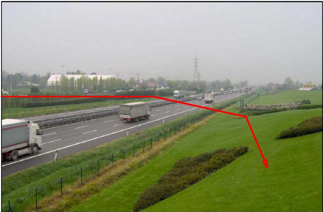
Foto 2 : Attraversamento SPBS11 "Tangenziale Sud di Brescia" e Autostrada A4
