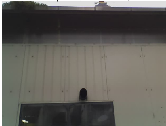
Bocchetta aerazione con valore di Leq pari a 90.0 dBA (misurato ad 1mt. di distanza).
