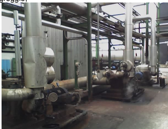
Valore di Leq pari a 94.0 dBA (misurato ad 1mt. di distanza).
