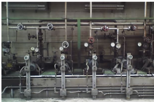
Valore di Leq pari a 88.0 dBA (misurato ad 1mt. di distanza).
