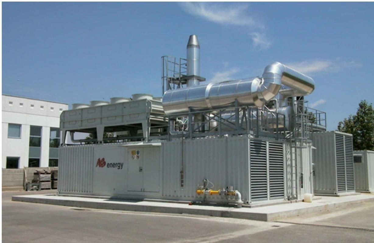
Il modulo cogenerativo è fornito installato in un container per esterno già corredato di tutte gli apparati per la messa in funzione. Le dimensioni tipiche sono le seguenti lunghezza ca. 15 metri, larghezza ca. 3 metri e altezza ca. 2,75 metri con esclusione, per l'altezza dei sistemi di dissipazione della potenza termica (vedasi all. 4 sketch modulo) con altezza totale del camino ca. 10 metri.
