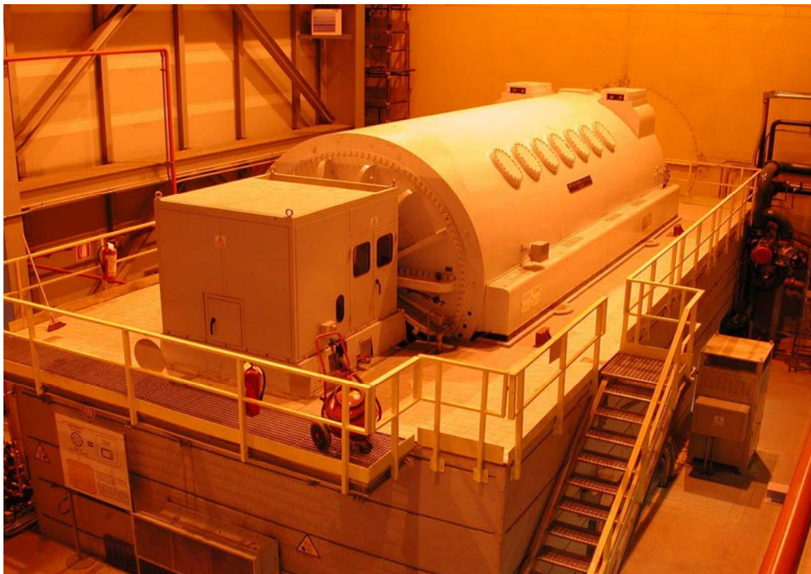
Figura 10 – Gruppo alternatore del turbogas
