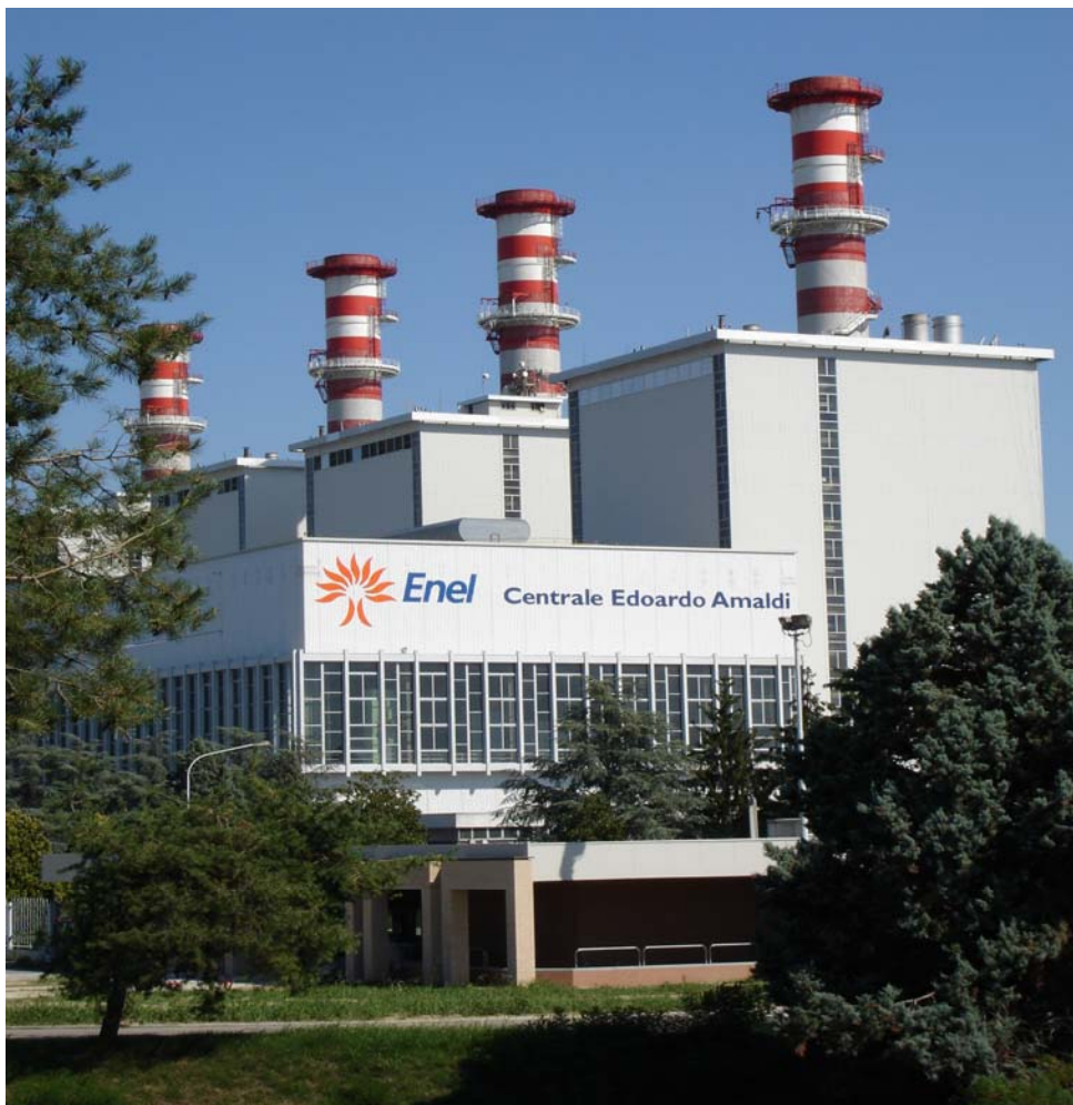
Figura 12 – Vista esterna dell'impianto di La Casella
