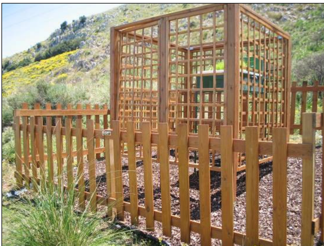
Figura 4 Vista generale del gabbiotto per l'alloggiamento dei biosensori attivi
