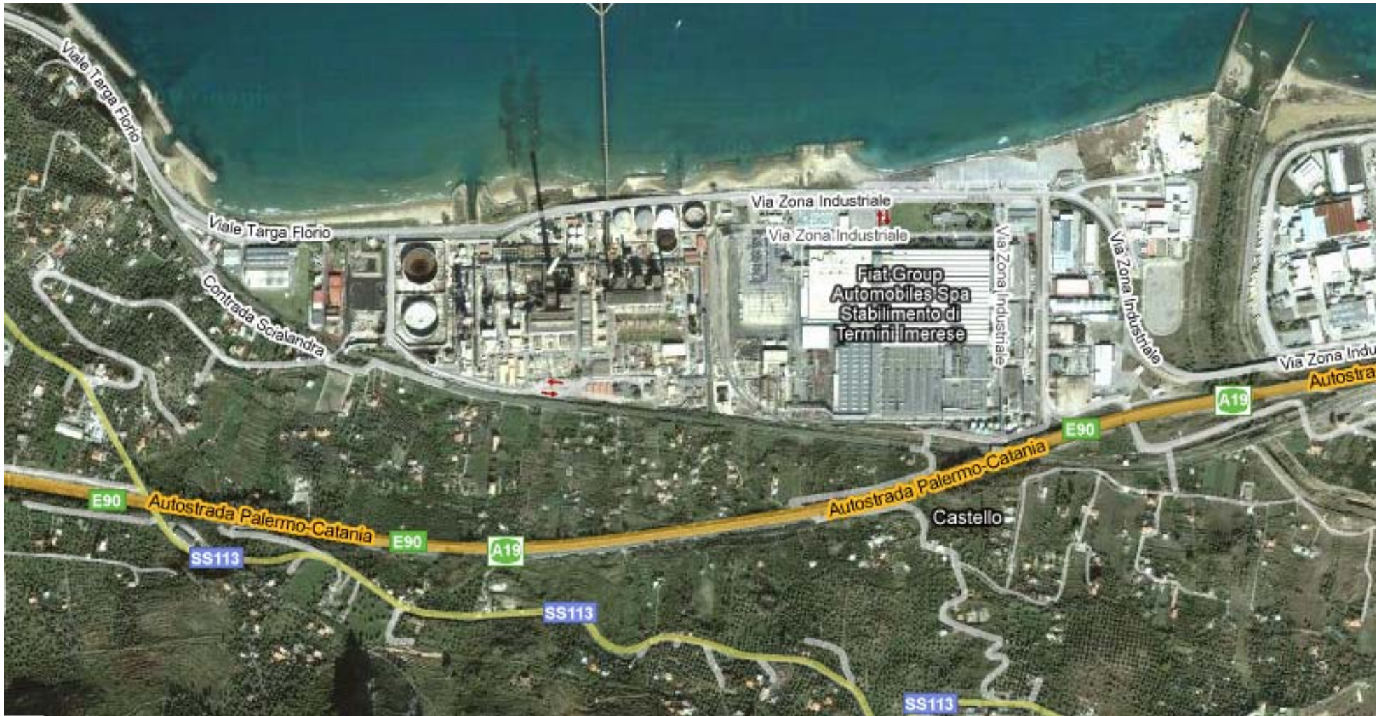
Fig. 1 – Centrale Termoelettrica Ettore Majorana di Termini Imerese - foto aerea
