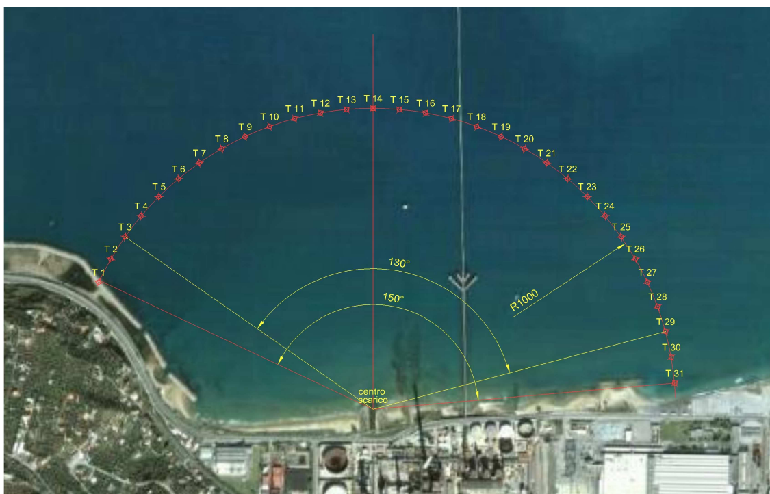
Fig.1 Veduta area della centrale termoelettrica Ettore Maiorana di Termini Imerese (PA) con riportata l'ubicazione delle 31 stazioni di misura sull'arco a 1000 m dal punto di restituzione delle acque di raffreddamento condensatori (fonte Google Earth)
