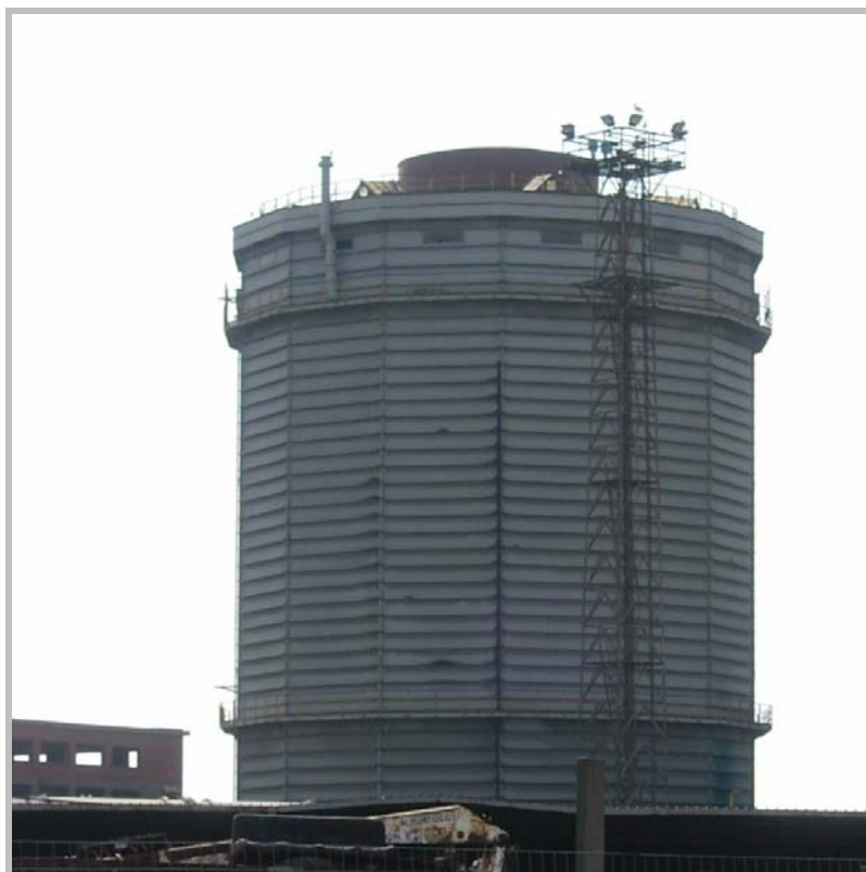
Figura 12 - Gasometro gas di Cokeria “Badoni”
