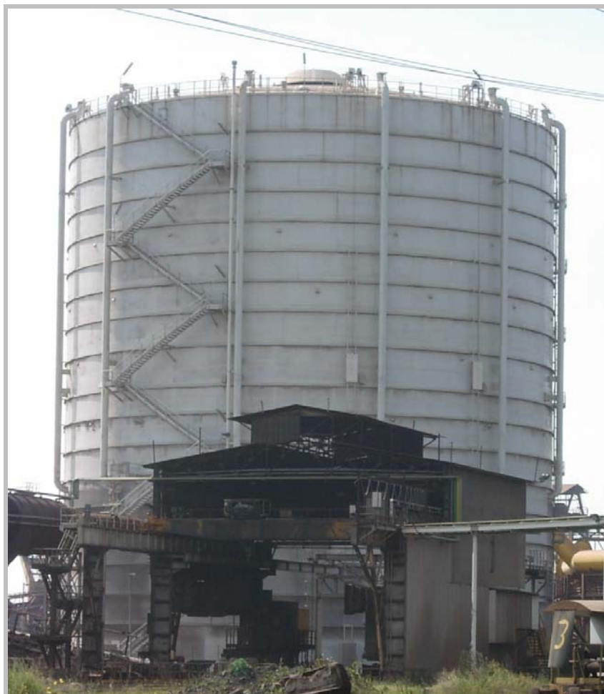
Figura 14 - Gasometro gas di Altoforno
