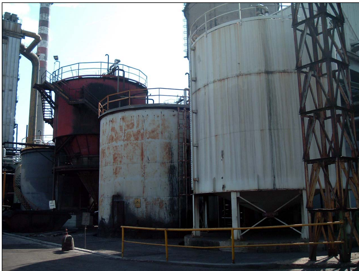
Figura 1: Serbatoi di catrame di cokeria
