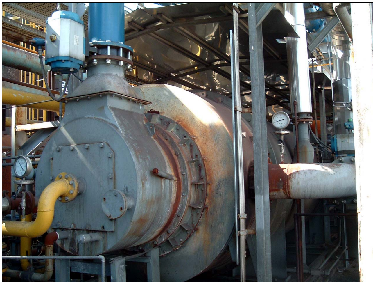
Figura 4: Impianto di defenolaggio
