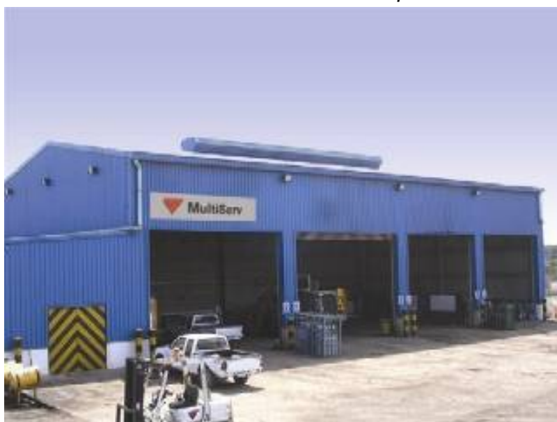
Foto n. 17 – Vista officina tipo -
