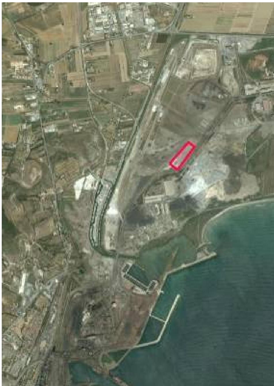
Foto n. 2 – Localizzazione impianto M.R.P. -
