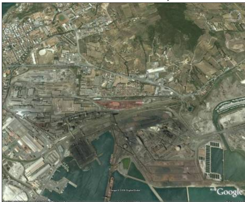
Foto n. 1 – Ubicazione nuovo impianto -
