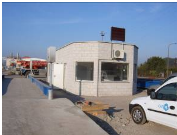
Foto n. 15 – Esempio box accettazione rottame -
