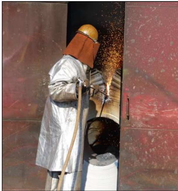
Foto n. 1 – Operazione di taglio manuale –
