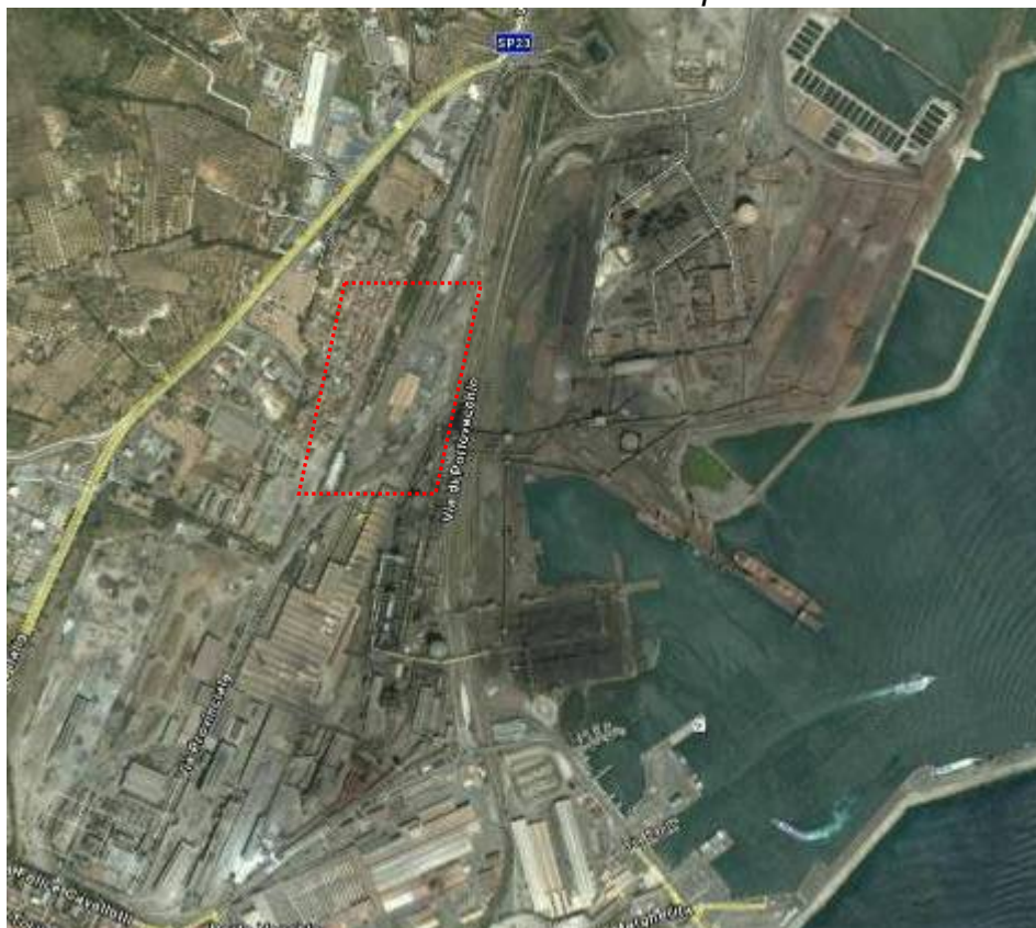
Foto n. 1 – Ubicazione nuovo impianto -
