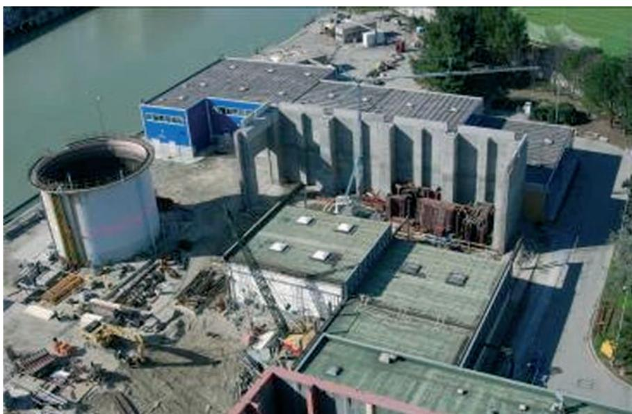
Figura 25. Particolare del cantiere. Si notano le nuove officine in alto ed a sinistra, il deposito gessi in fase di costruzione, il magazzino e le vecchie officine demolite in primo piano
