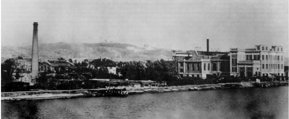
Figura 4: Centrale Termoelettrica delle Officine elettriche dell'Isonzo (1913): costituisce il primo impianto di generazione termoelettrica sorto sul sito dell'attuale centrale.
