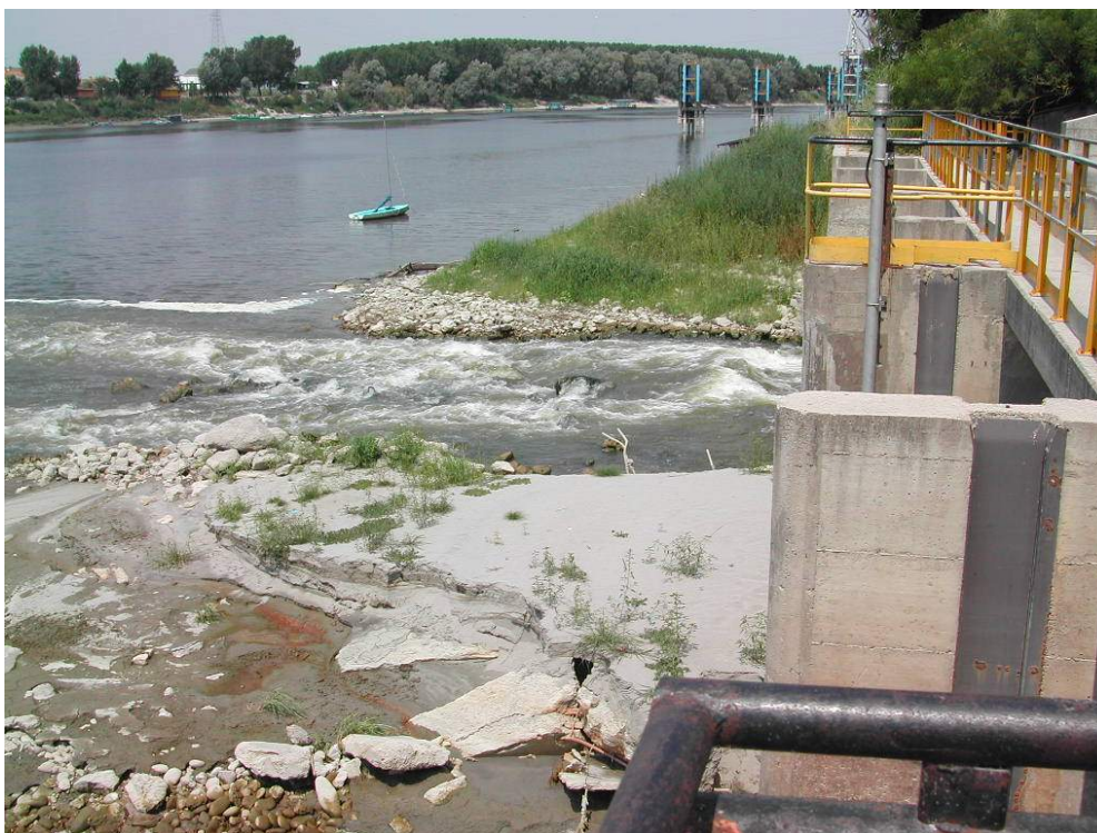
Figura 7 – Opera di scarico
