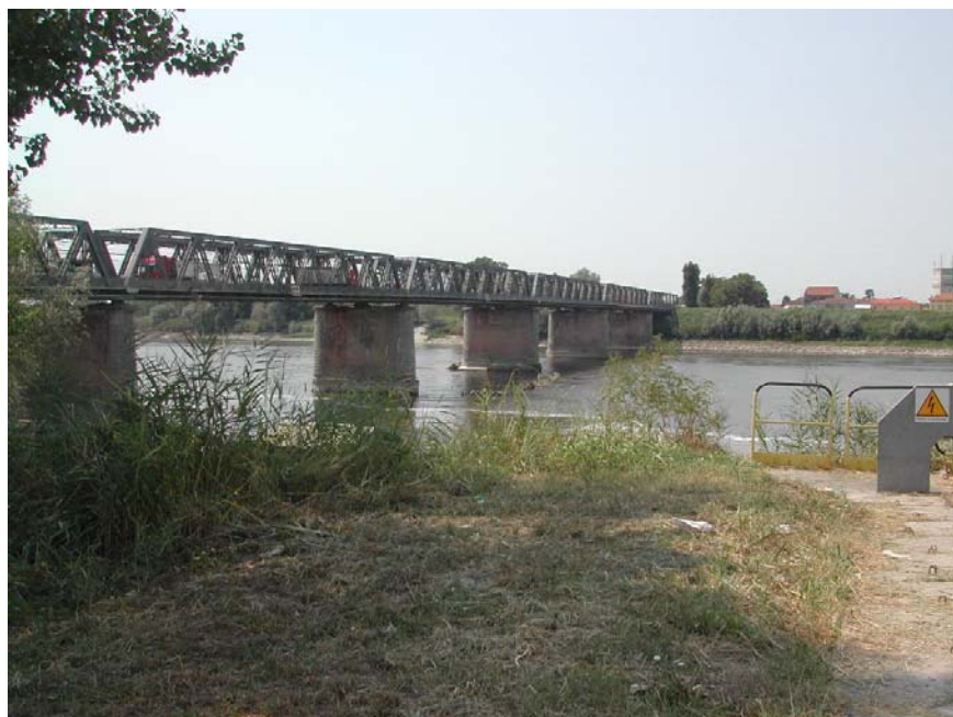
Figura 6 - Ponte stradale (SS 12) e ferroviario tra Revere ed Ostiglia visto dall'opera di scarico
