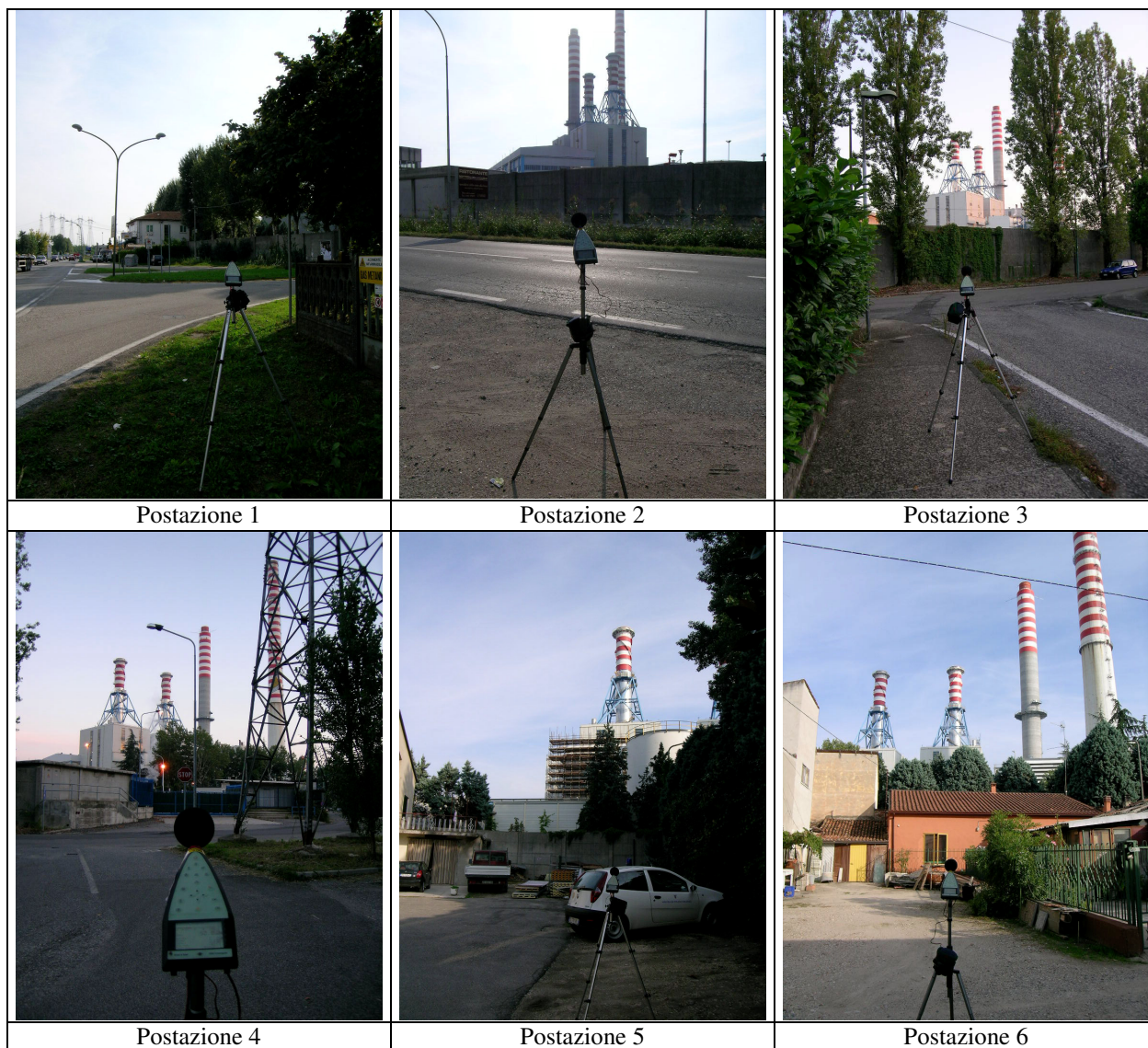
Figura III – Immagini fotografiche dell'impianto dai punti di misura - I
