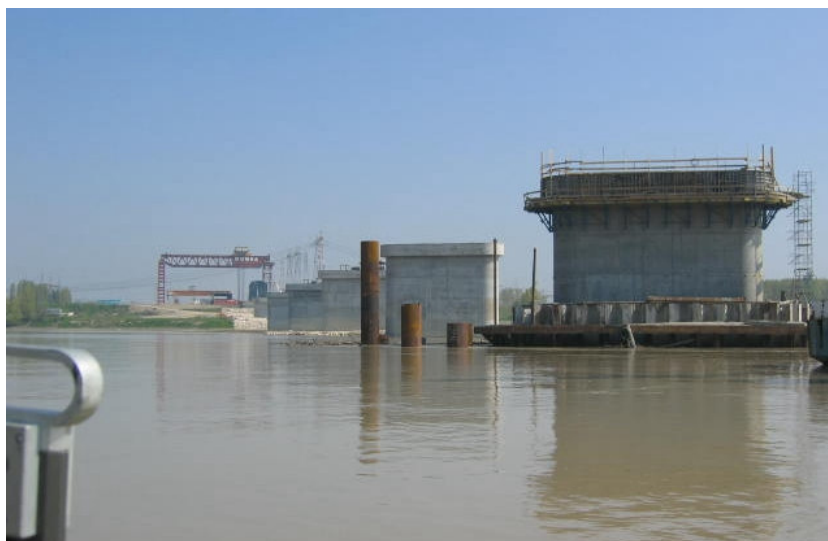
Figura 5 – Vista dalla sponda destra del fiume Po delle pile del costruendo nuovo ponte ferroviario per il raddoppio della linea Bologna – Verona (aprile 2007)
