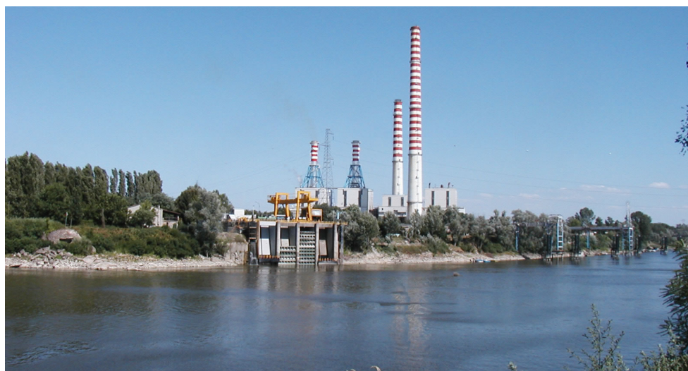
Figura 3 – Vista dell'opera di presa dalla sponda destra del Po (da Rif. 3)
