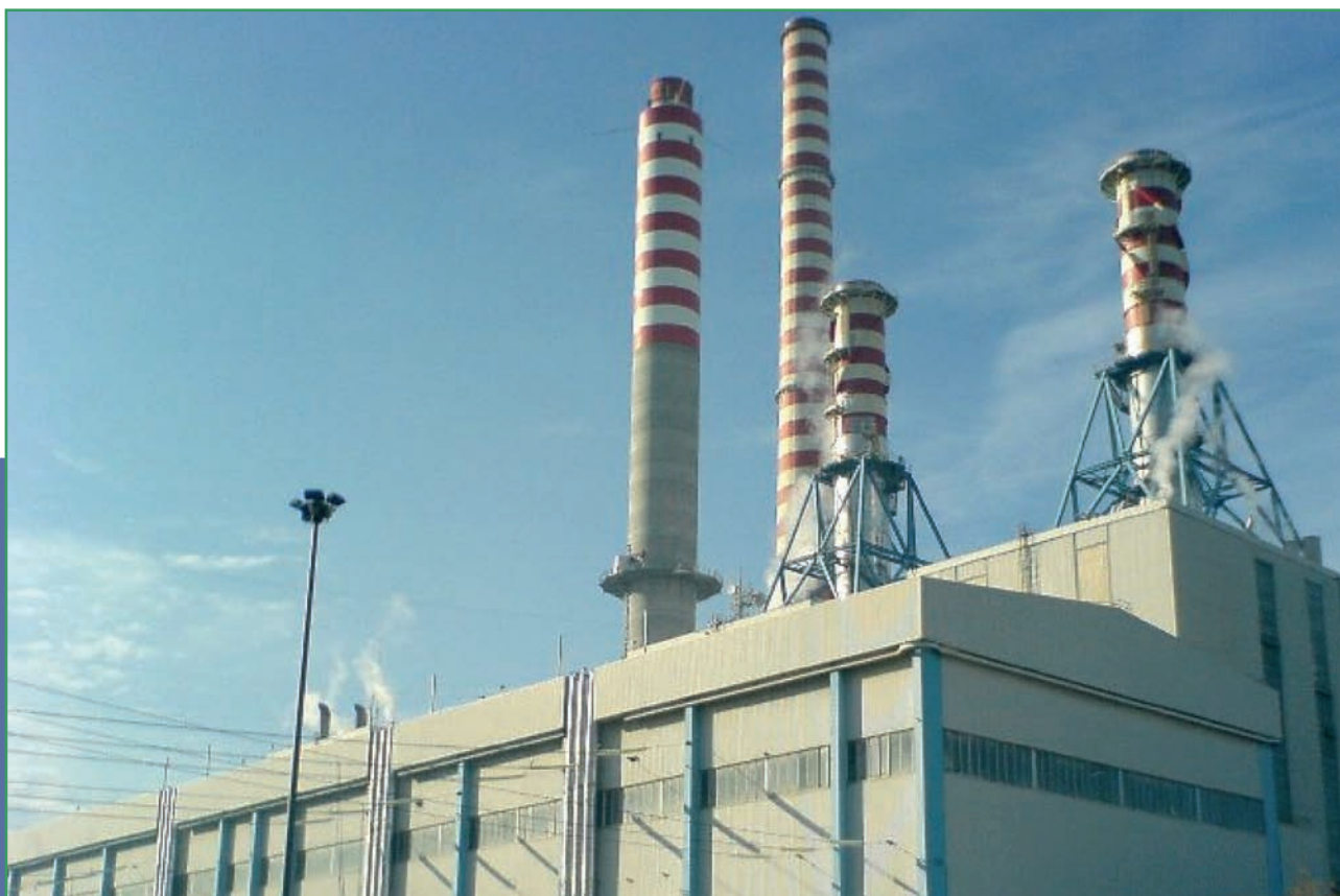
Figura 3: La centrale di Ostiglia
