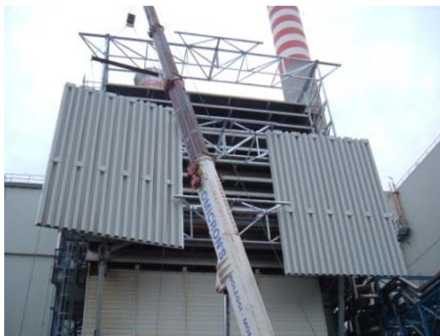
Fasi costruttive delle barriere acustiche posizionate sui TGA e TGC
