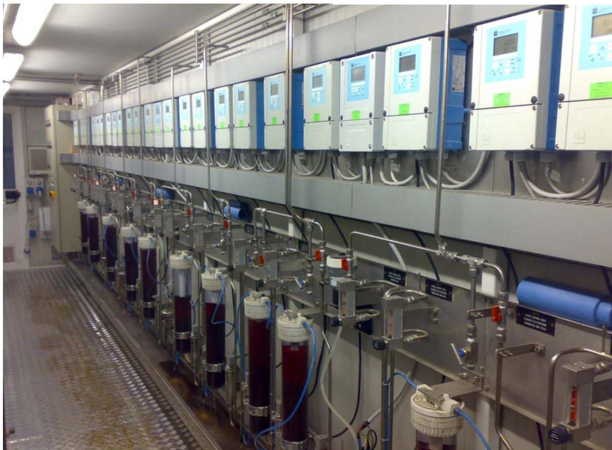
Fig. 28 – monitoraggio parametri chimici acqua del ciclo termico
