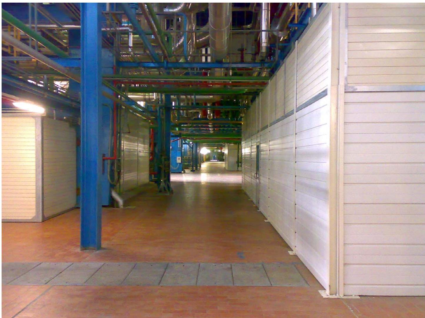
Fig. 20 – Corridoio di sala macchine – interventi di insonorizzazione dei macchinari
