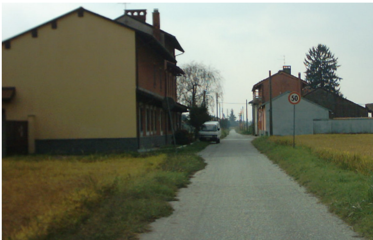
Recettore 5 - Pozzaccio Nuovo: vista del recettore
