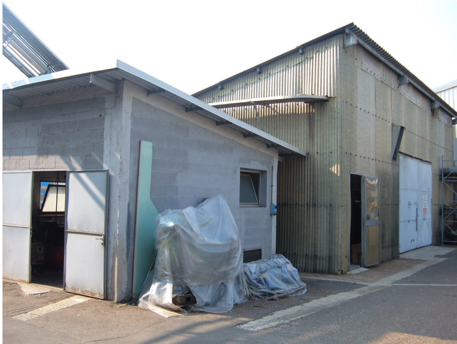
Area G: Officina – Particolare delle palazzine di ubicazione dei generatori e compressori
