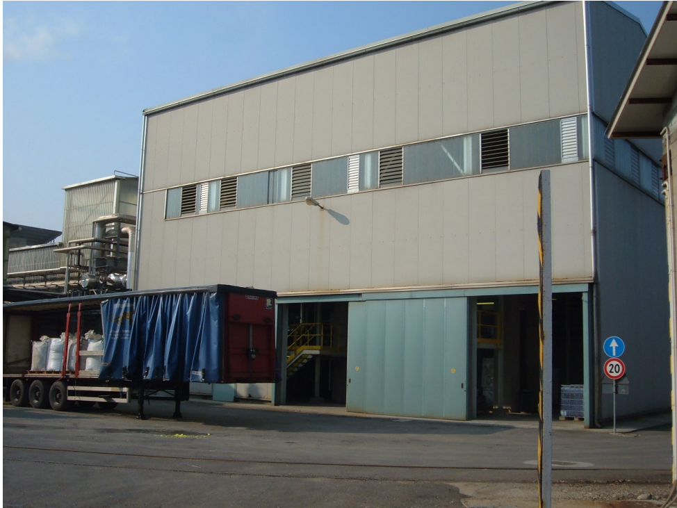
Area D: Area turbina + Torri – Particolare dell'alloggiamento della turbina
