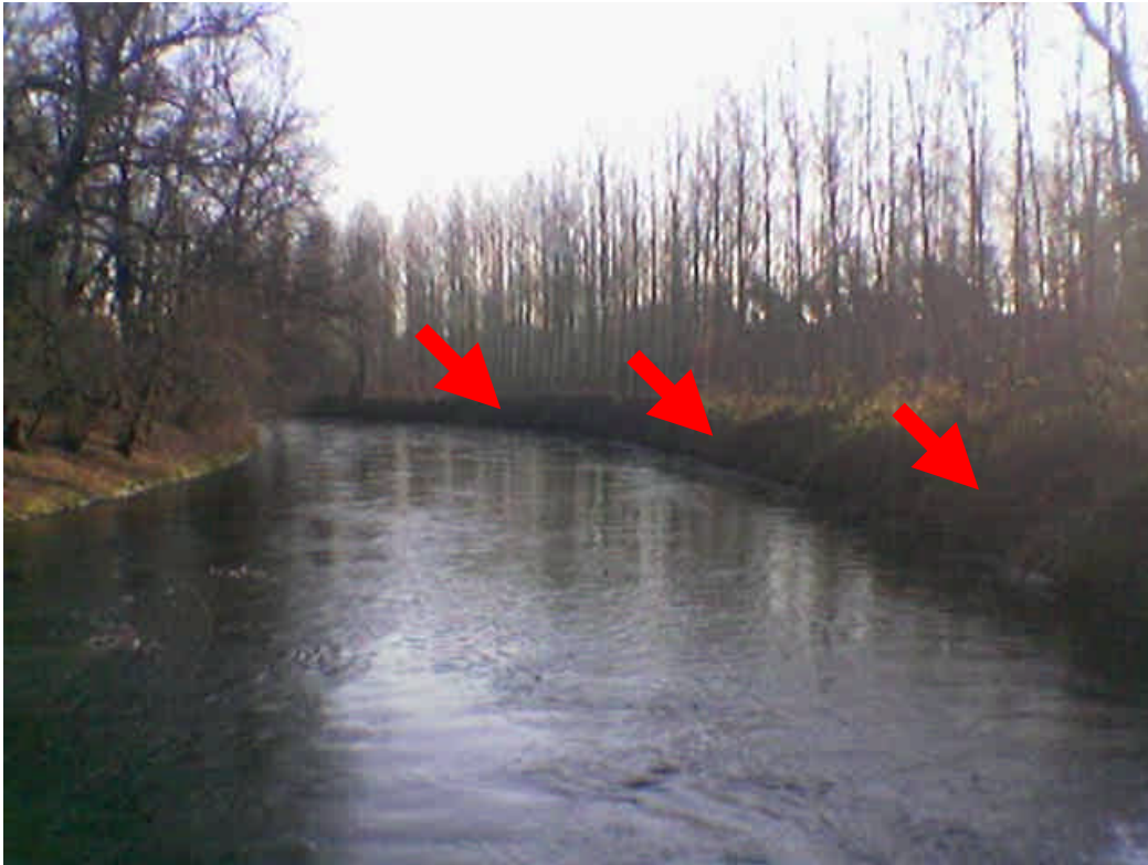
Foto 11 – Naviglio Sforzesco, punti di ancoraggio stazione SFO V
