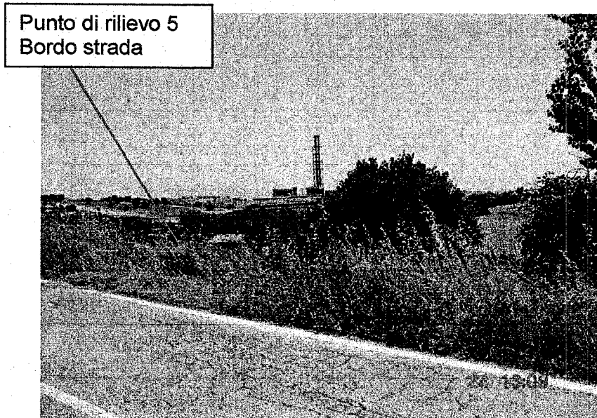
Punto 5 : Rilievo su bordo strada (loc. la casella), fronte centrale
