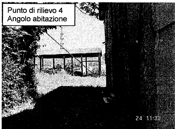
Punto 4 :Rilievo angolo abitazione, fam. Passaquieti, fronte centrale
