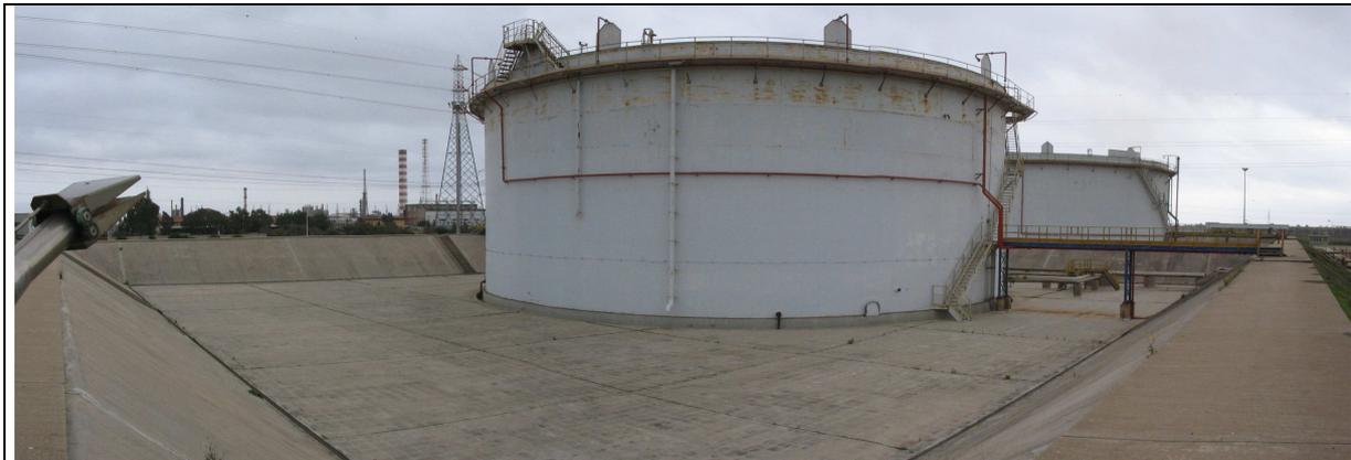
**Figura 3:** serbatoi di stoccaggio e relativo bacino di contenimento
