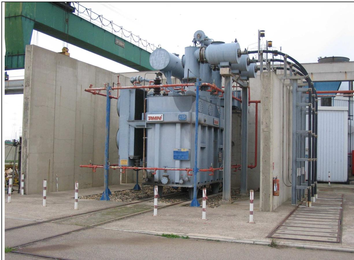
**Figura 10:** *trasformatore da 100 KVA (160-15 KV)*
