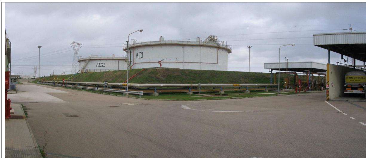
**Figura 7:** tubazioni fuori terra per il trasferimento del combustibile
