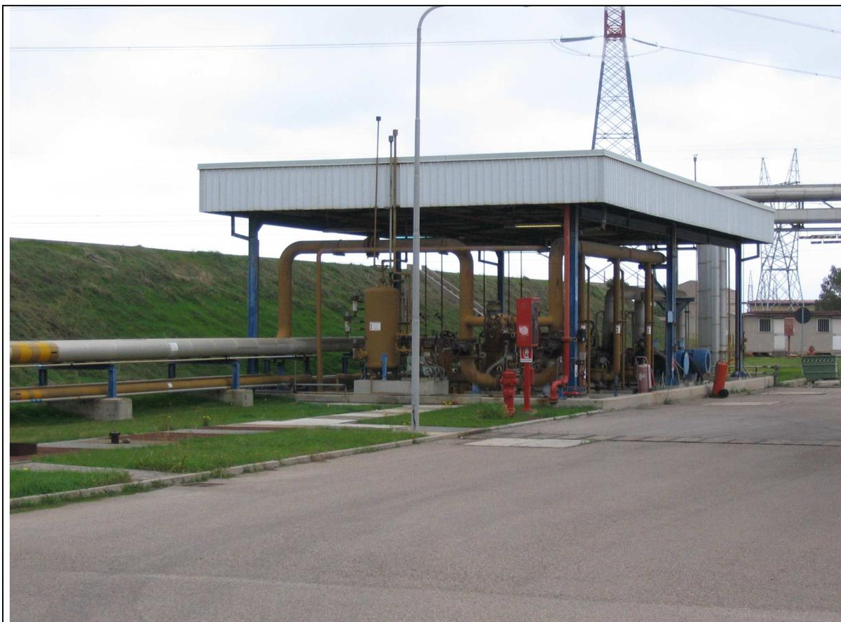
**Figura 5:** tettoia pompe trasferimento gasolio
