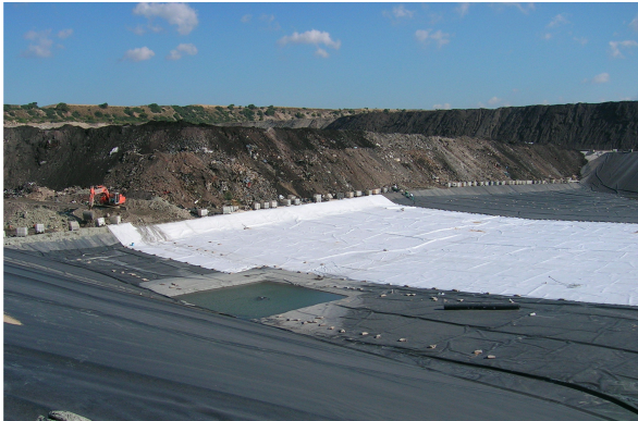
Realizzazione 3° lotto – Posa in opera geotessile di protezione geomembrana
