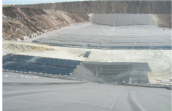
Realizzazione 3° lotto – Posa in opera geomembrana in HDPE
