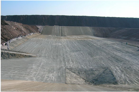
Realizzazione 3° lotto - Strato di impermeabilizzazione del fondo con argilla
