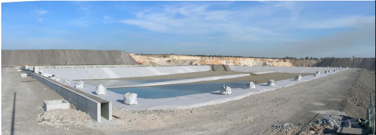
Vista d'insieme del 1° modulo ad avvenuta posa in opera del secondo strato drenante
