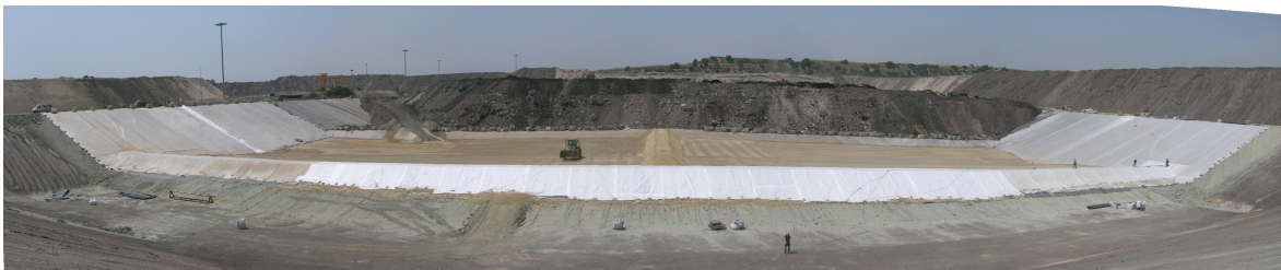
Vista d'insieme del 3° lotto ad ultimazione realizzazione
