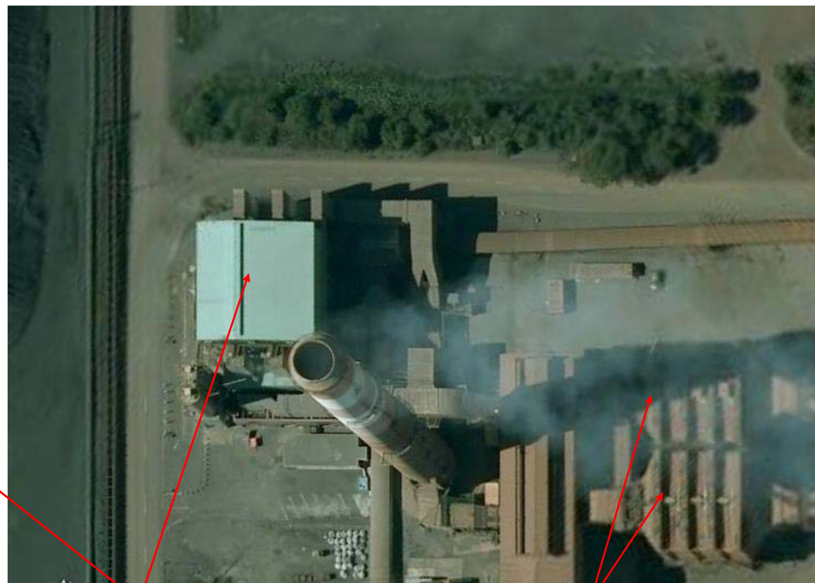
Impianto di abbattimento con filtro a tessuto realizzato su uno dei due collettori
