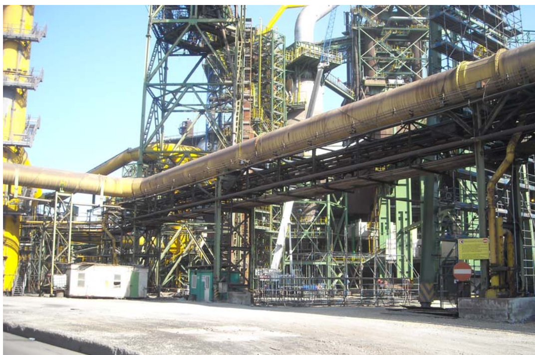
FOTO 2 – particolare dell'area nella quale era presente il deposito oli da avviare in AFO/4
