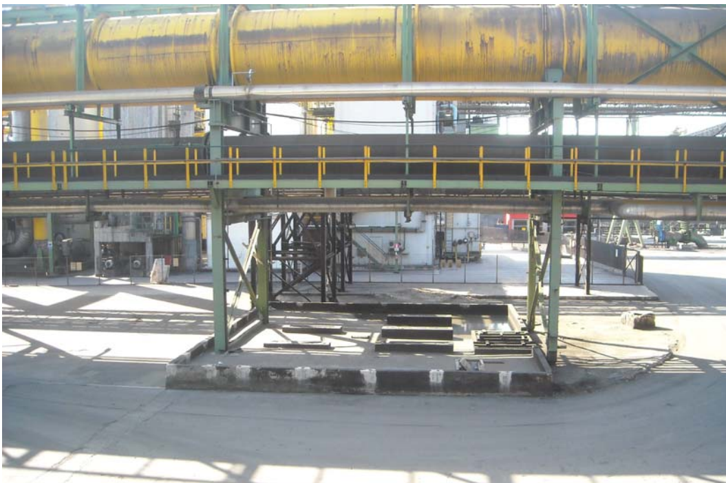
FOTO 1 – particolare dell'area nella quale era presente il deposito oli da avviare in AFO/2
