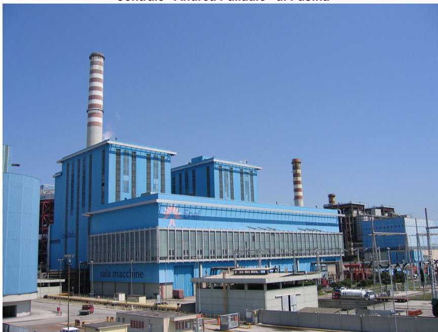
Centrale “Andrea Palladio” di Fusina
