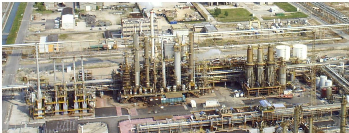
Figura 7: Impianto CV 22/23 di Ineos Vinyls Italia
