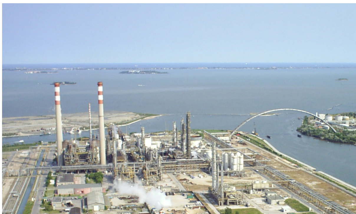
Figura 10: Impianto di cracking di Polimeri Europa
