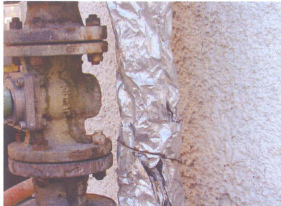
fettuccia di tracciatura livello strumentale DP 350 - 351
