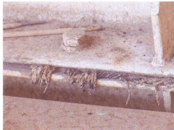
camino dei forni: treccia utilizzata come guarnizione
