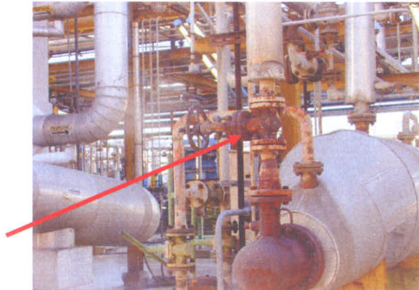
il cuscino in tessuto di amianto è stato rimosso
