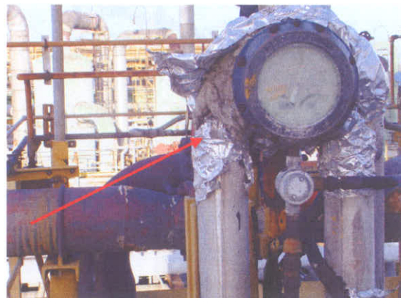
fettuccia in crisotilo confinata nel misuratore di portata
