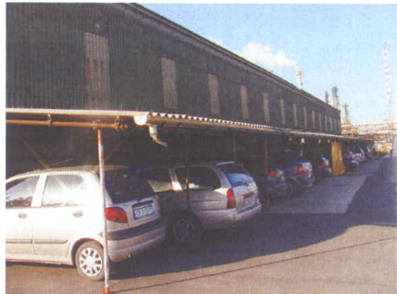
tettoia in eternit; parete in eternit
