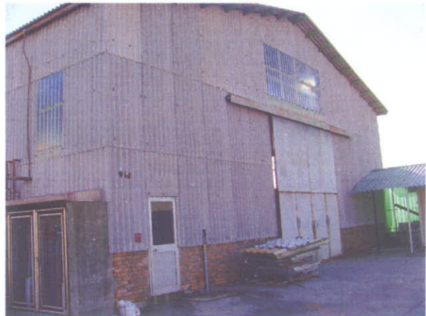
copertura e pareti del magazzino 10
