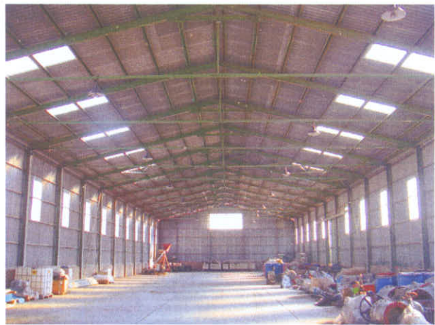
copertura e pareti del magazzino 10
