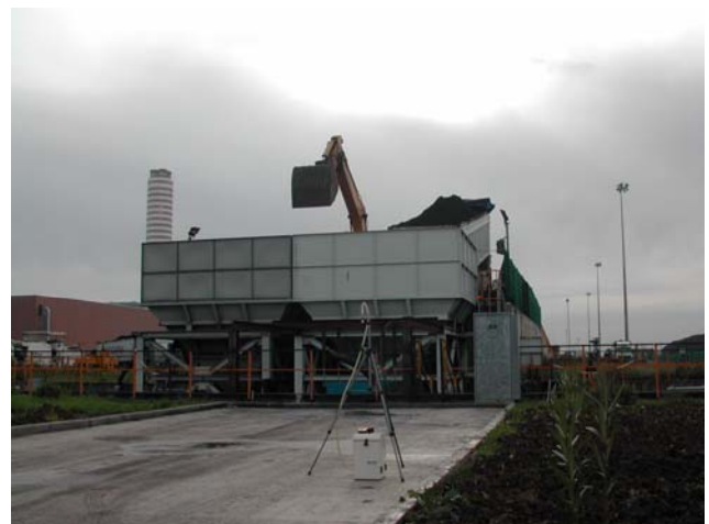
Campionamento dello scarico dei camion in tramoggia N22-N23
