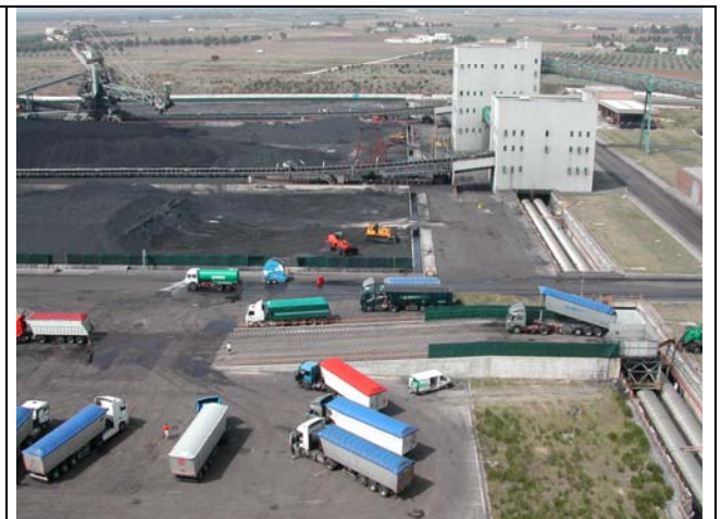
Trasferimento del carbone dall'automezzo al nastro afferente le caldaie mediante le tramogge N22-N23
