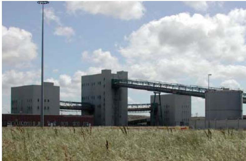
Torre T13-T11-T12 per il trasferimento del carbone a/da parco (da sinistra a destra)
