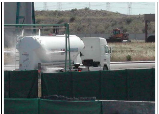
Impianto di lavaggio automezzi attualmente utilizzato
