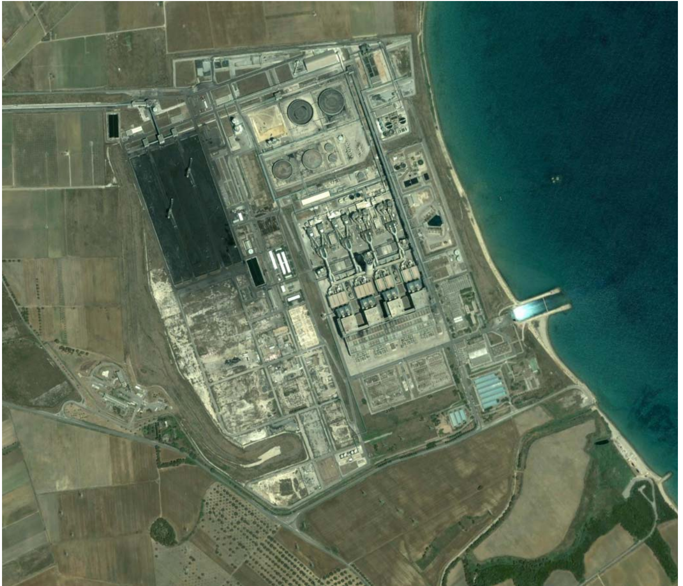
Fig. 2.1 – Vista satellitare della centrale termoelettrica "Federico II" di Brindisi Sud
