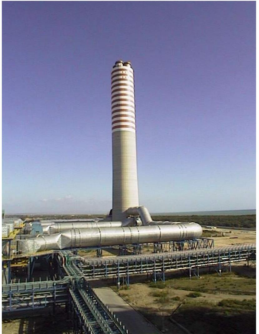
Le principali emissioni in atmosfera derivanti dal processo di combustione nelle caldaie dei gruppi a vapore, fuoriuscenti dalla ciminiera principale alta 200 metri, sono rappresentate da SO<sub>2</sub> (biossido di zolfo), NO<sub>x</sub> (ossidi di azoto), CO (monossido di carbonio), CO<sub>2</sub> (anidride carbonica) e Polveri.
