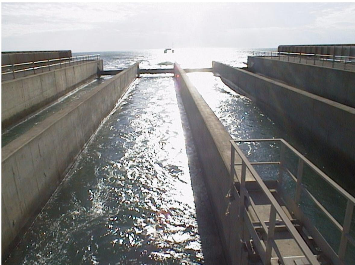
L'acqua prelevata per il processo di condensazione del vapore e raffreddamento degli impianti è convogliata al mare attraverso uno scarico generale sul quale vengono effettuate attività di monitoraggio sia in continuo sia a carattere discontinuo per verificarne il rispetto dei limiti fissati dal D.Lgs. 152/99.
