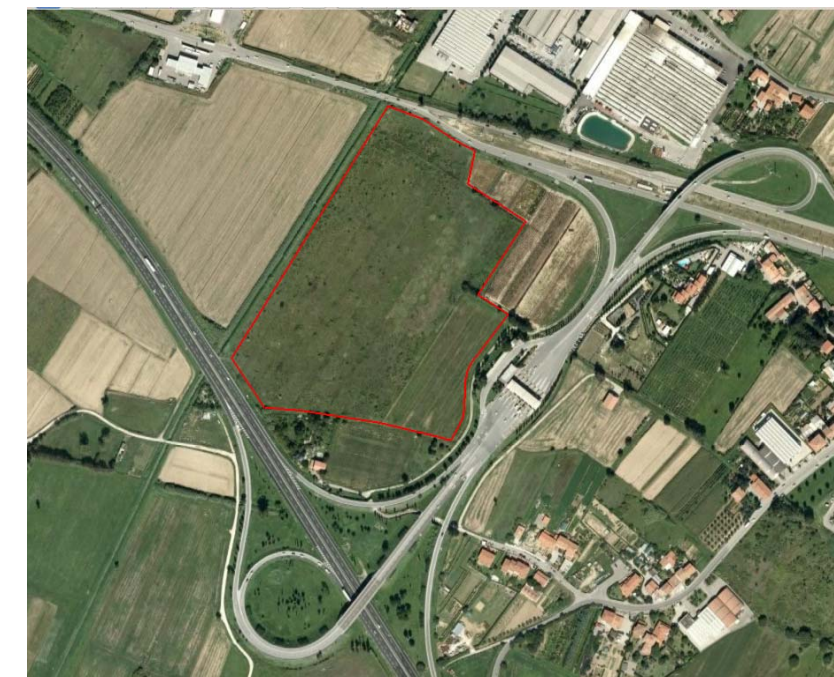
Foto aerea dell'area del cantiere
