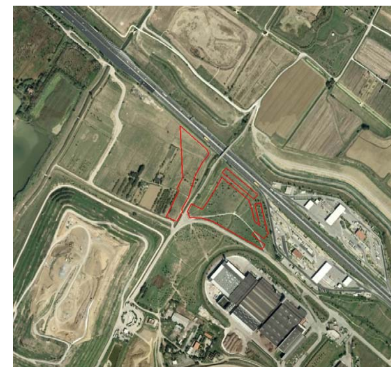
Foto aerea dell'area del cantiere
