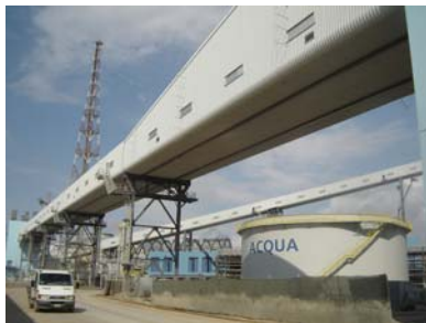
Figure a – Esempio di nastri trasportatori coperti e tipologia di nastri (posizione 152,164,167 e 172 dell'All. C.11 della Scheda C)
