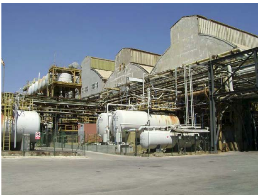
Figura 3-1: Sala celle – vista esterna
