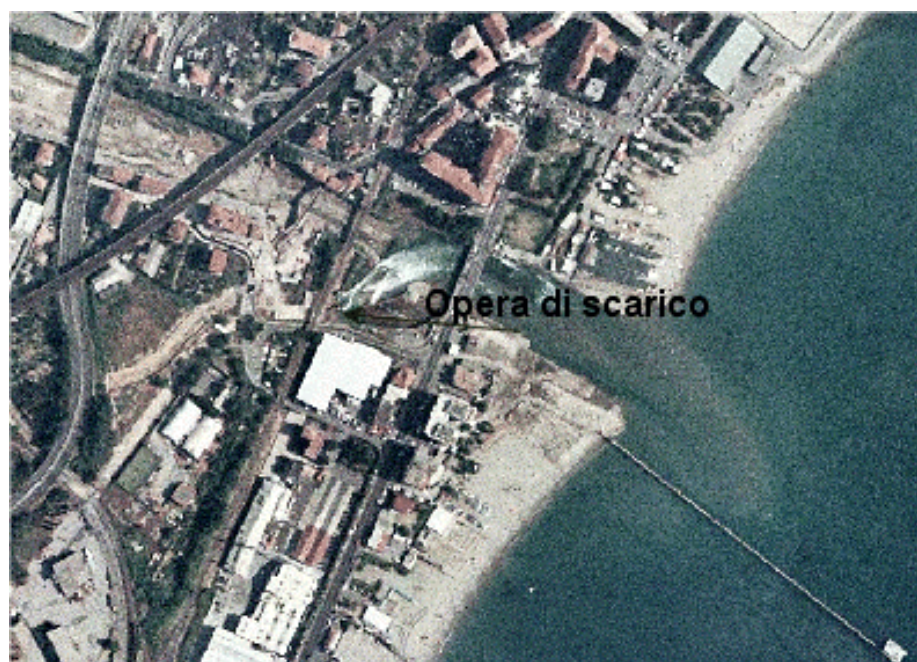
fig. 2.3 – Opera di scarico. Vista aerea
