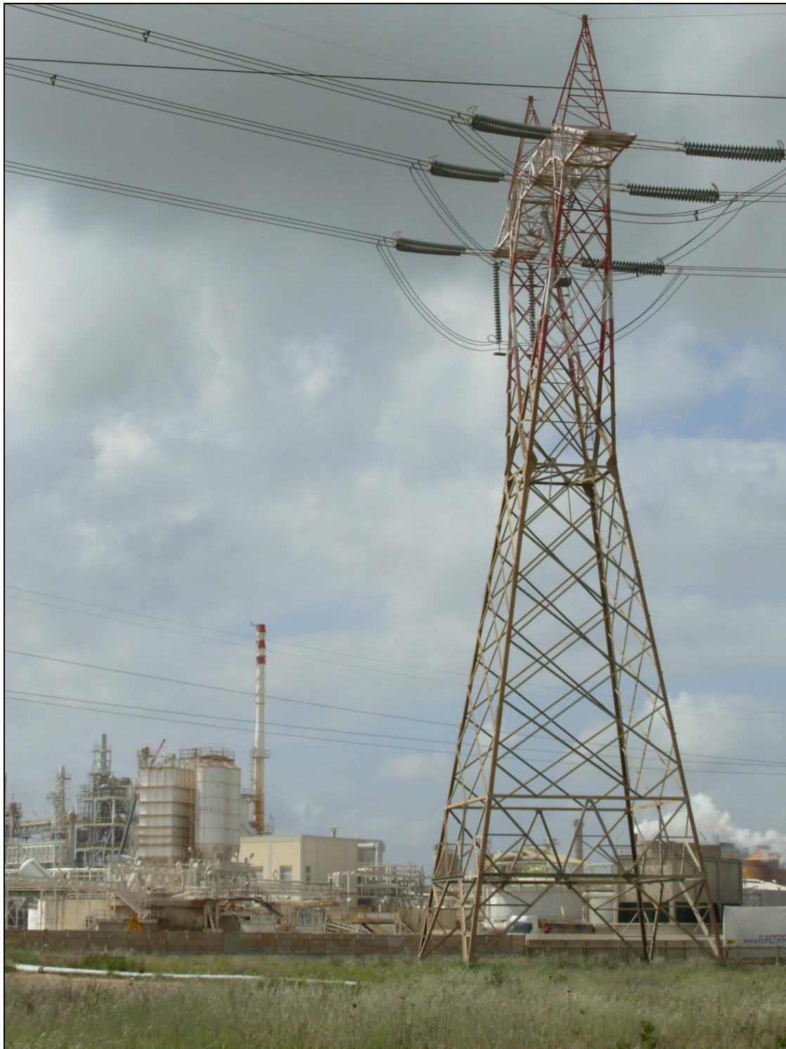
Figura 25 - Particolare dell'area industriale di Macchiareddu
