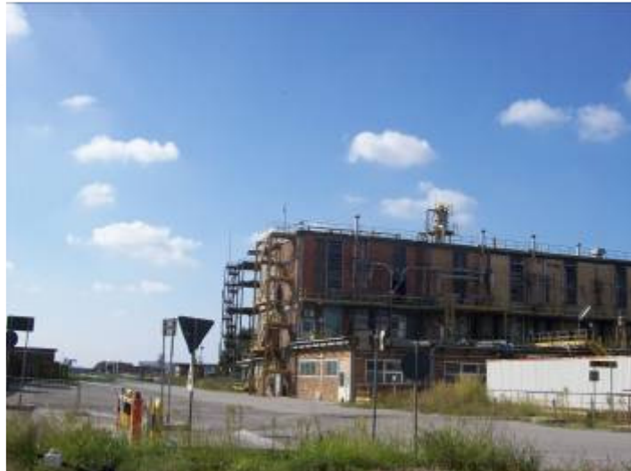
Area Stoccaggio, Perimetro Nord – Vista sull'area industriale prospiciente
