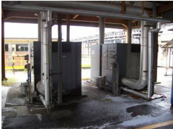
Postazione 19 – Impianti FC819A e C823 (Compressori per Trasporto Polimeri) Vista Posteriore
