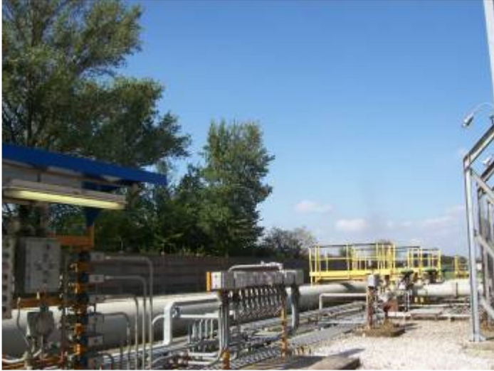
Area Torce – Vista Lato Ovest
