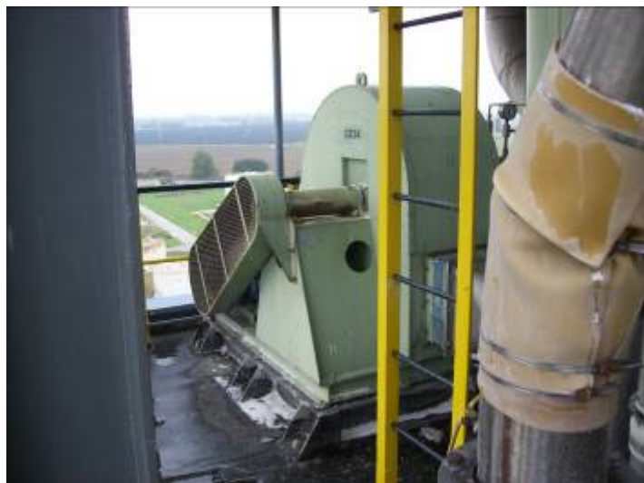
Postazione 17 – Impianto C834 (Captazione Polveri Siletti Estrusione) Il piano di calpestio dell'impianto è situato a 31,2m dal suolo
