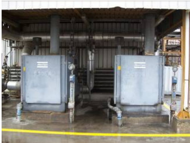
Postazione 6 – Impianti C506A, C506B Compressori per Trasporto Polimeri
