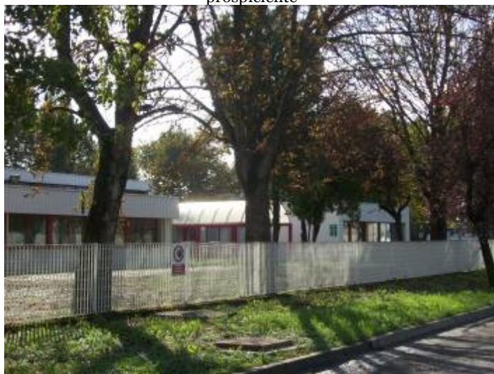
Area Stoccaggio – Perimetro Sud-Est – Vista sull'area di uffici prospiciente
