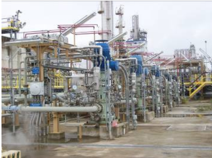
Postazione 26 – Pompe PO01 (Pompe del parco di stoccaggio monomeri) – Vista frontale, verso Sud Il piano di calpestio è situato a 1m al di sotto del livello del terreno circostante.
