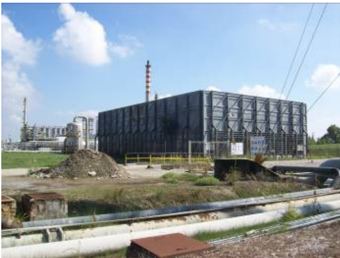
Area Torce – Vista Lato Nord
