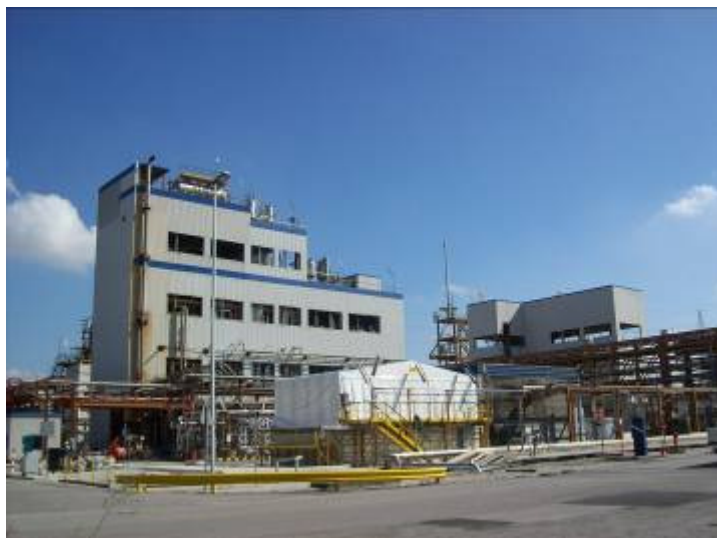
Area 24, Perimetro Est – Vista sull'area industriale prospiciente (Basell, Produzione polimeri), Area Catalizzatori
