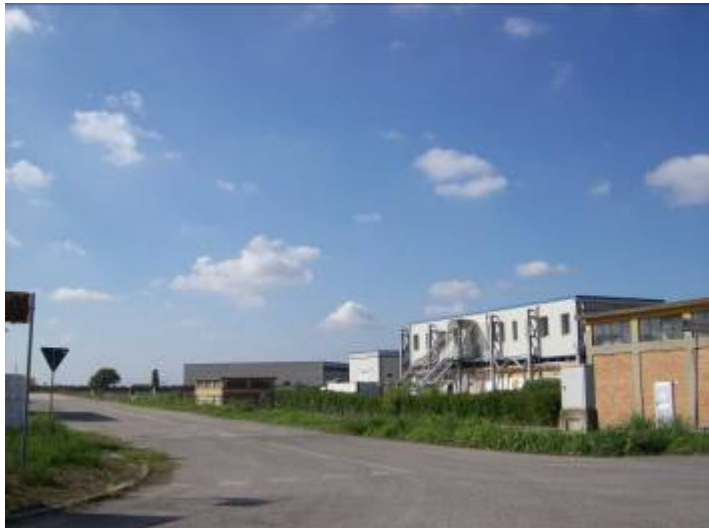
Area MPX LPG, Perimetro Nord – Vista sull'area industriale prospiciente
