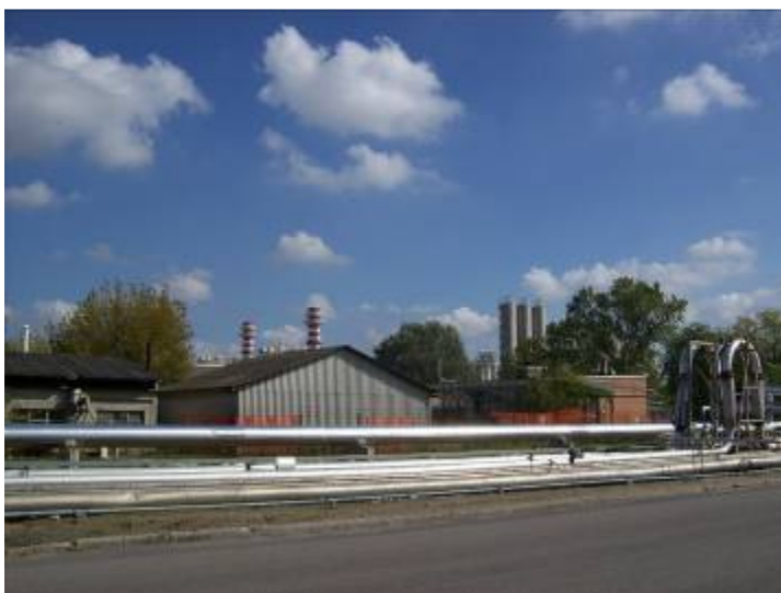
Area MPX LPG, Perimetro Est – Vista sull'area industriale prospiciente
