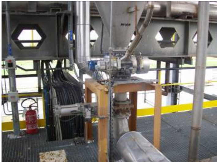
Postazione 22 – Linea di Trasporto aria dalla Sileria 200m 3 Il piano di calpestio è situato a 8m di altezza dal suolo.
