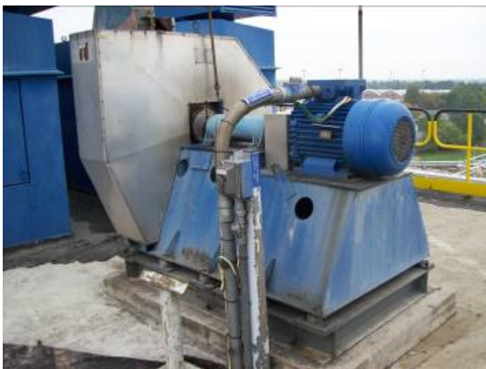
Postazione 22 – Linea di Trasporto aria dalla Sileria 200m 3 Il piano di calpestio è situato a 8m di altezza dal suolo.
