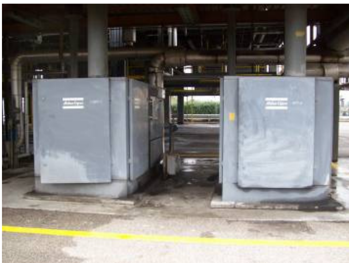
Postazione 19 – Impianti FC819A e C823 (Compressori per Trasporto Polimeri) Vista Frontale
