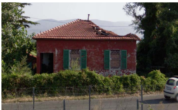
Figura 32 – Casa cantoniera in demolizione
