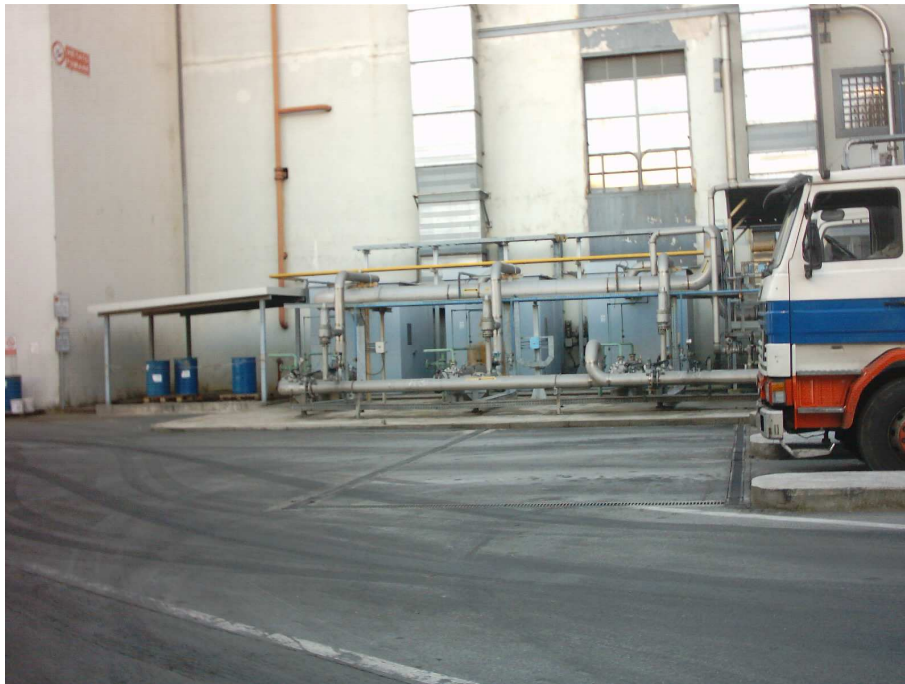
Area Scarico TPA (S9)
