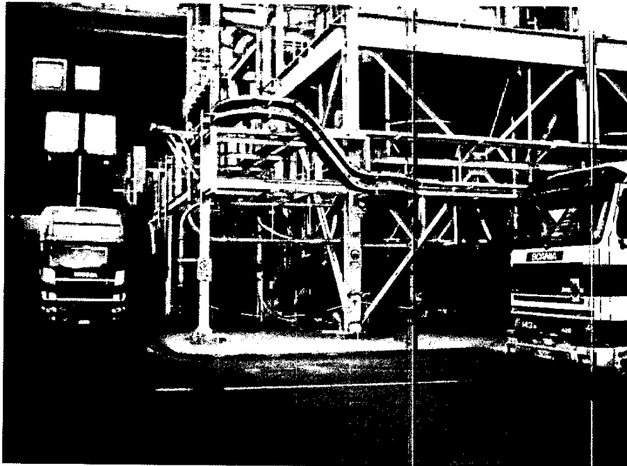
Area Stoccaggio Chips: particolari delle sorgenti S7- silos e S8 – Product cooling area
