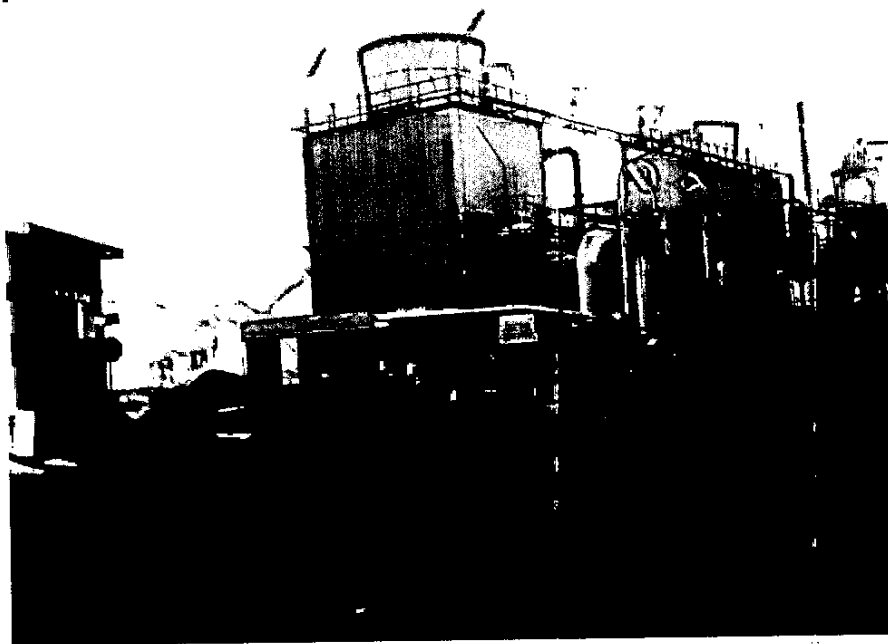
Torri di raffreddamento (S1) lato sud
