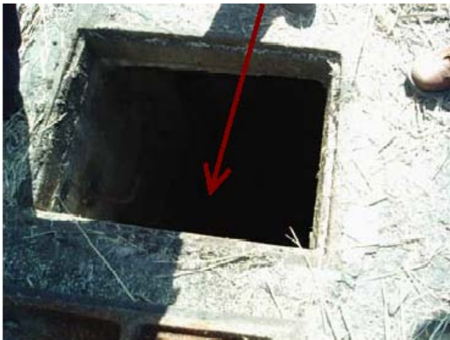
Figura 7 - Ultimo pozzetto sulla tubazione del refluo proveniente dall'Impianto di Osmosi
