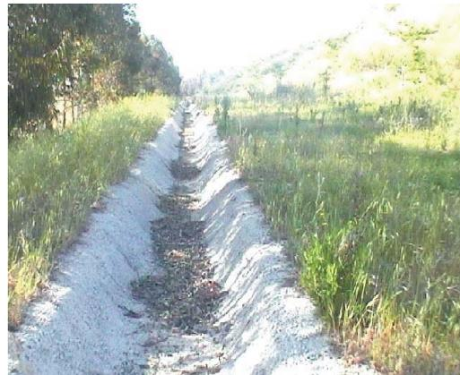
*Particolari della canaletta perimetrale per la captazione delle acque di ruscellamento*
