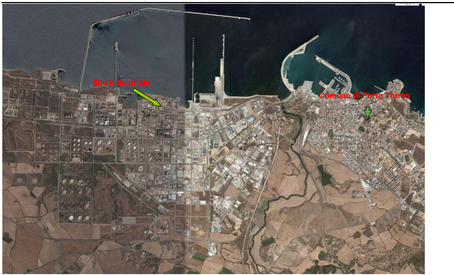
Figura D8.2.2a Ubicazione dello Stabilimento (Immagine Satellitare)
