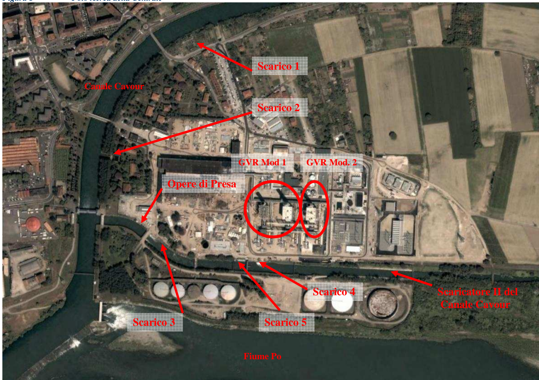
Figura 1 Foto Aerea della Centrale
