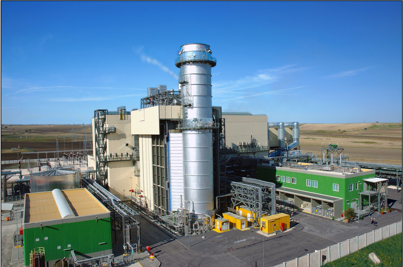
Figura 3: Foto della Centrale Termoelettrica di Candela
