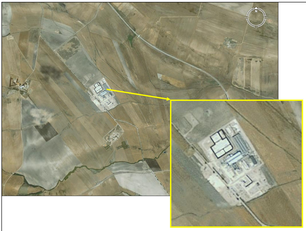
Figura 1: Foto aerea della Centrale di Candela (Fonte: Google Earth)
