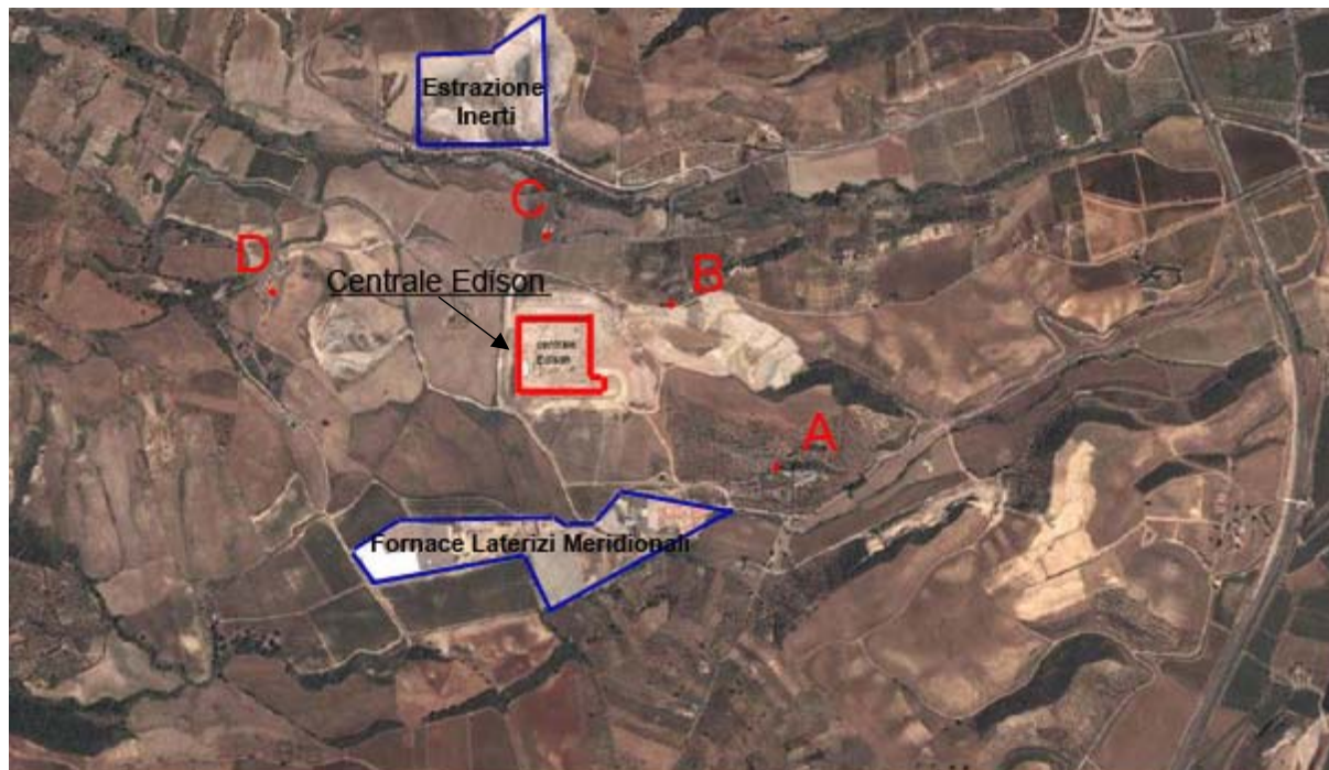
Figura 1 – vista area circostante alla centrale
