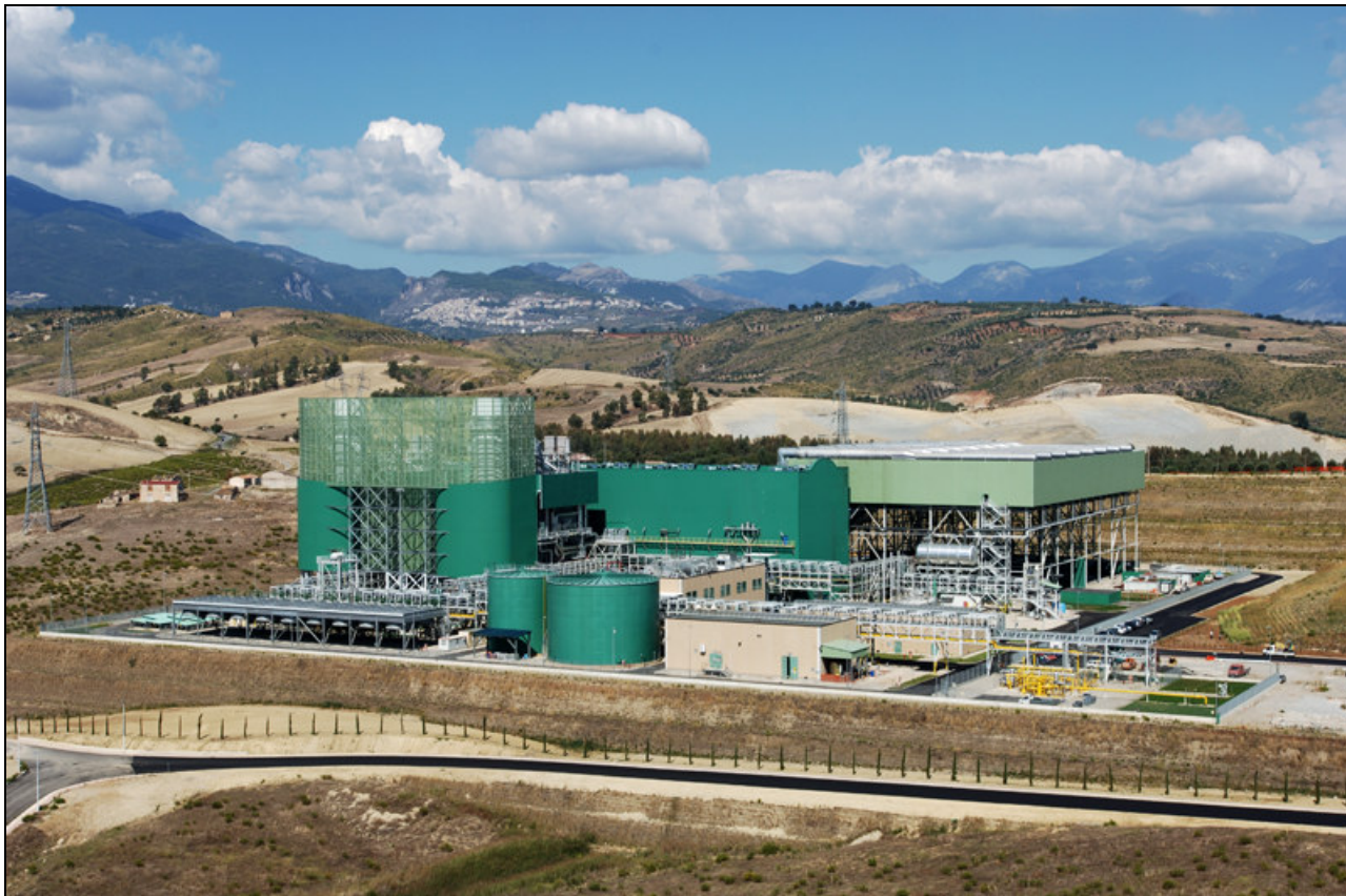
Figura 3: Foto della Centrale Termoelettrica di Altomonte
