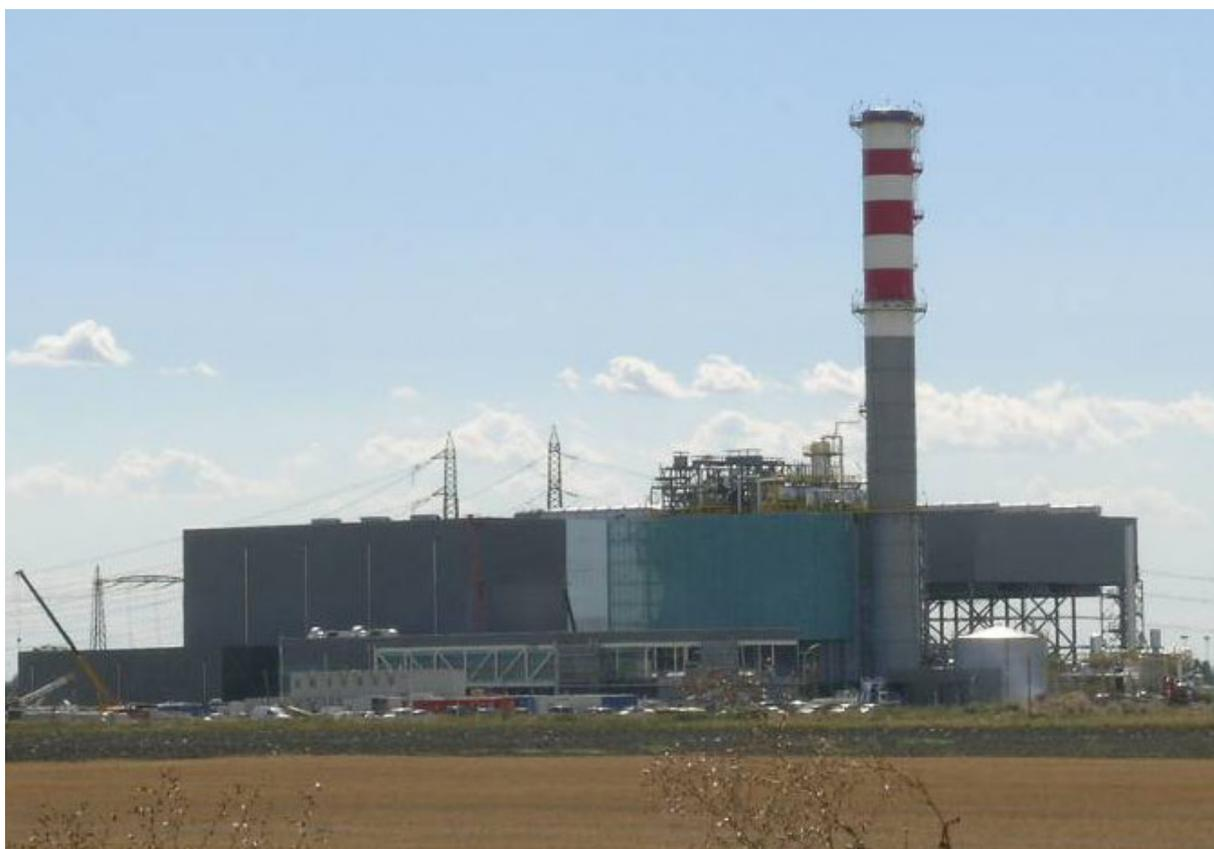
**Figura 2.2 – Centrale di Voghera Energia: struttura di mascheramento dell'HRSG**
